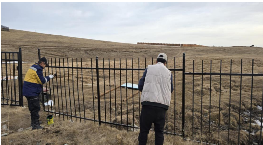
Зураг 12. Хашианы өнгийг сэргээн засаж зэврэлтээс хамгаалж буй байдал
