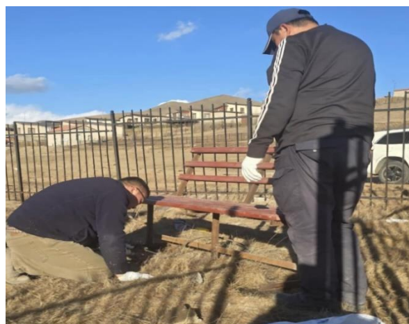
Зураг 16. Амрах сандал суурьлуулж байгаа байдал.
