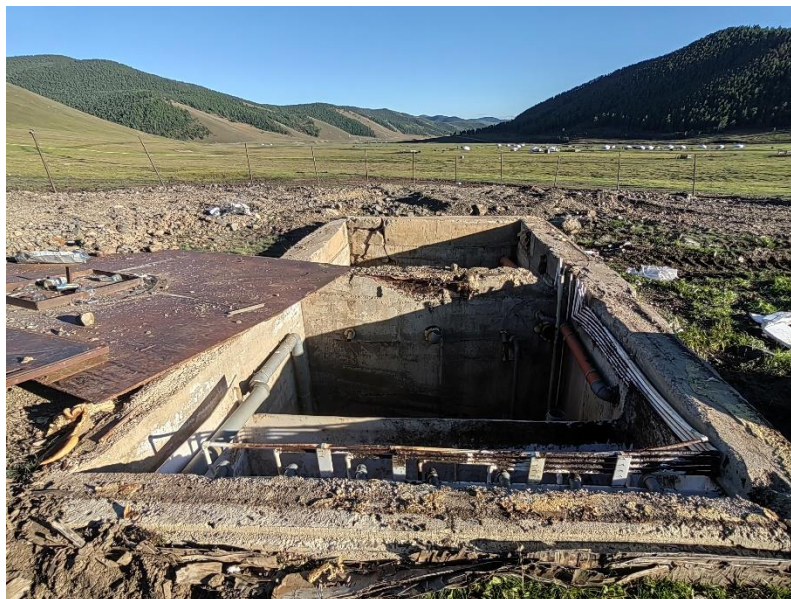
Зураг № 11 Ахуйн цэвэрлэх байгууламж янзалж буй байдал
