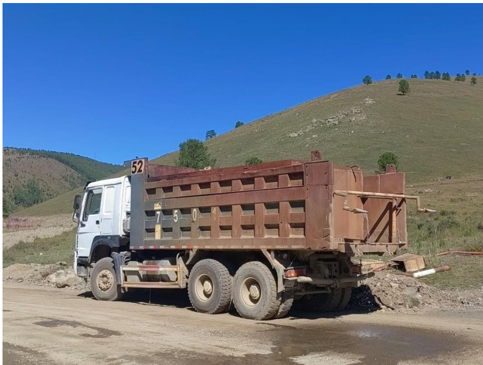
Зураг № 5 Зам усалгааны ажил хийгдэж буй байдал
