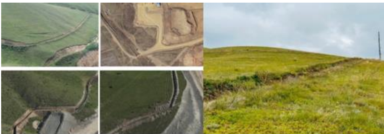
Зураг 41. Үерийн усны хамгаалалтын суваг шуудуу татсан байдал
