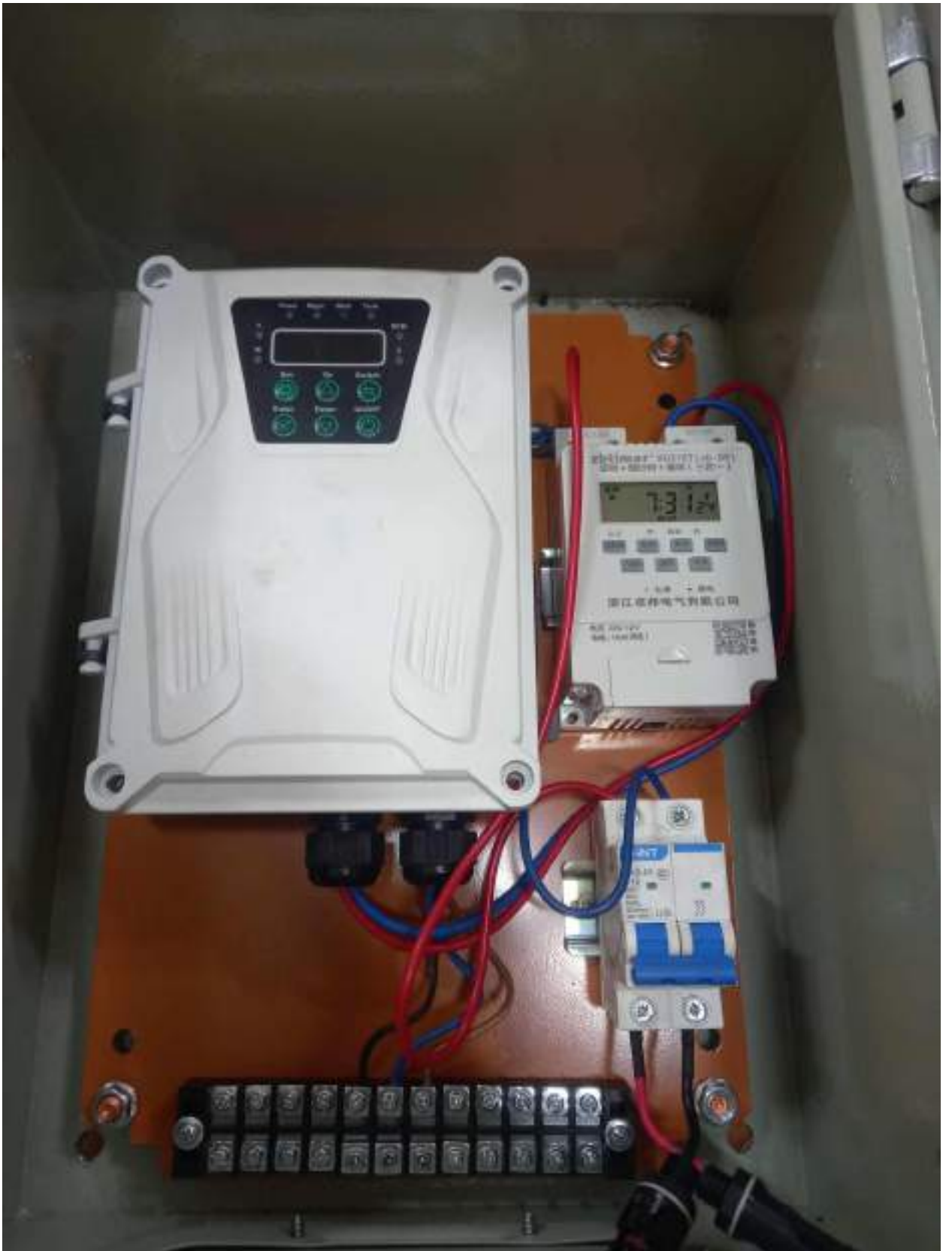
Худгийн удирдлагын самбар, цагийн релейг IP65-тай хайрцагт суурилуулав.
