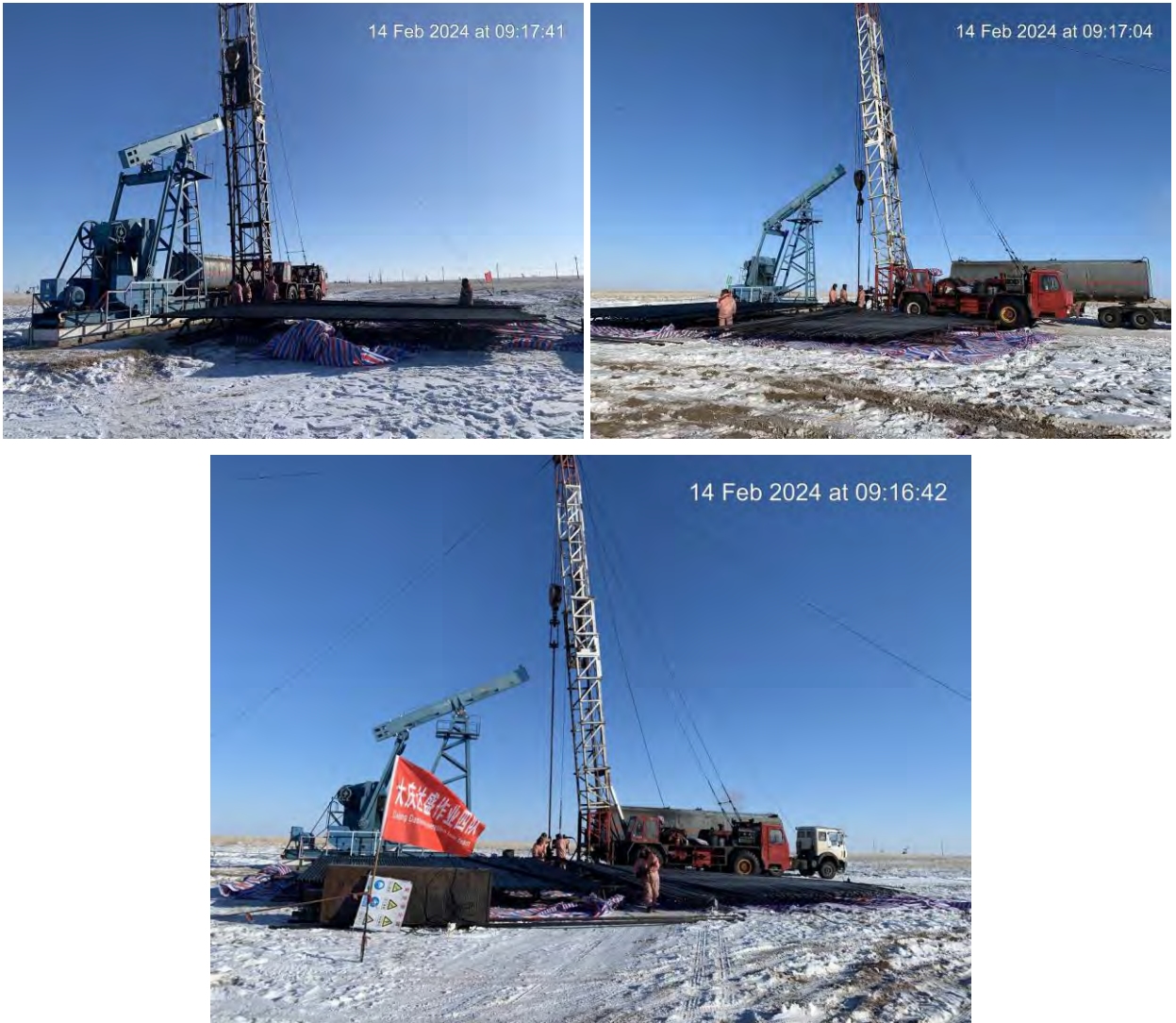
Зураг-6. Цооног үйлчилгээний үеэр, хөрсөнд үл нэвчир дэвсгэр дэвсэн байдал
