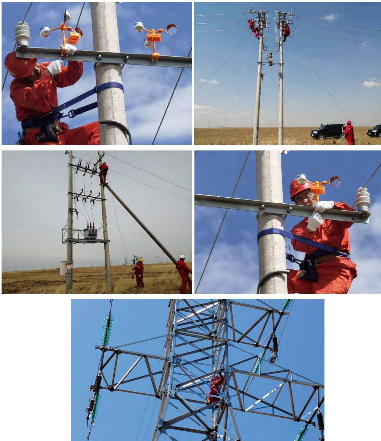
Зураг-45. Шувуу үргээгч суулгаж буй байдал
