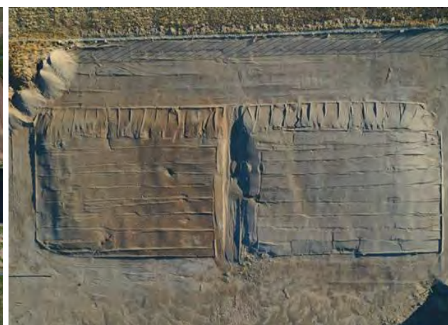
Зураг-29 Үйлдвэрийн шингэн хаягдлын сангийн техникийн нөхөн сэргээлтийн хийгдсэн байдал
