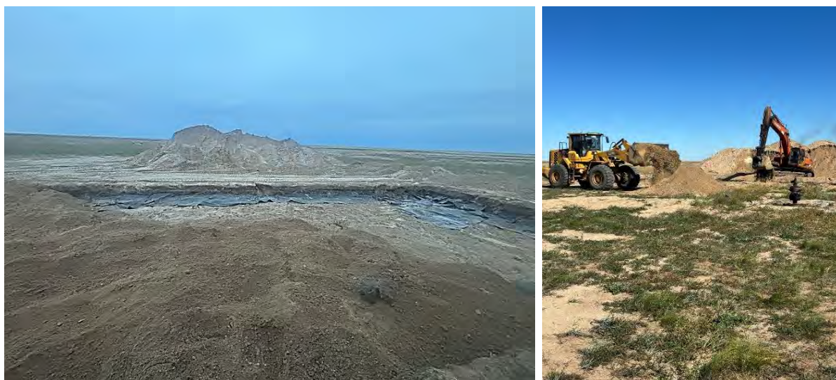
Зураг-19. Зүмпэнд шар шороон хөрс хийж дүүргэлт хийж буй байдал
