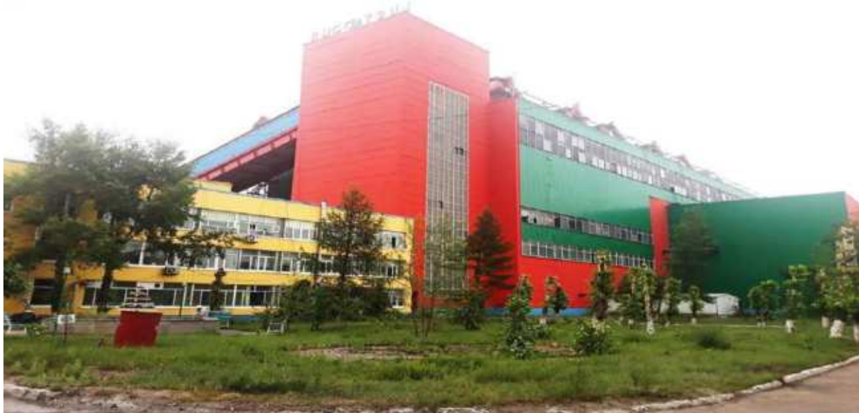
Зураг 20. Дулааны цахилгаан станц
