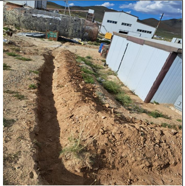
Зураг 45. Хаягдал тосны агуулахыг үерийн ус орхоос сэргийлж шуудуу ухсан
