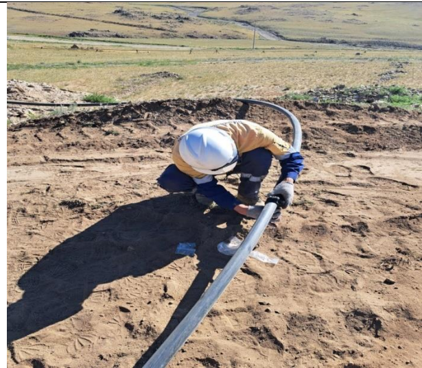
Зураг.73 Усалгааны систем холболт хийж байгаа нь
