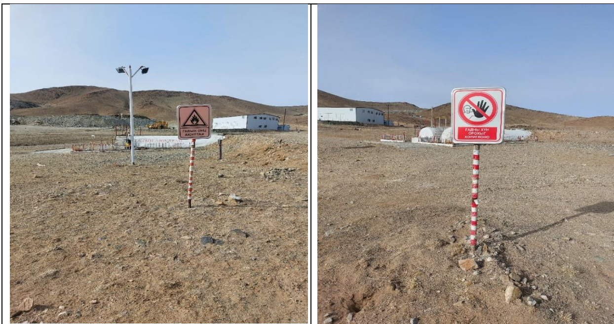
Зураг 10. Шатахуун түгээх станц
