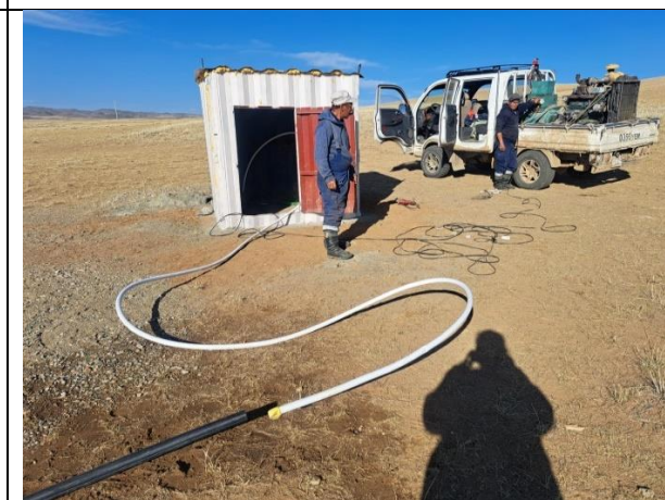
Зураг.83 Сумын худгийн байрыг байршуулж насосын ажиллагааг шалгаж байгаа нь
