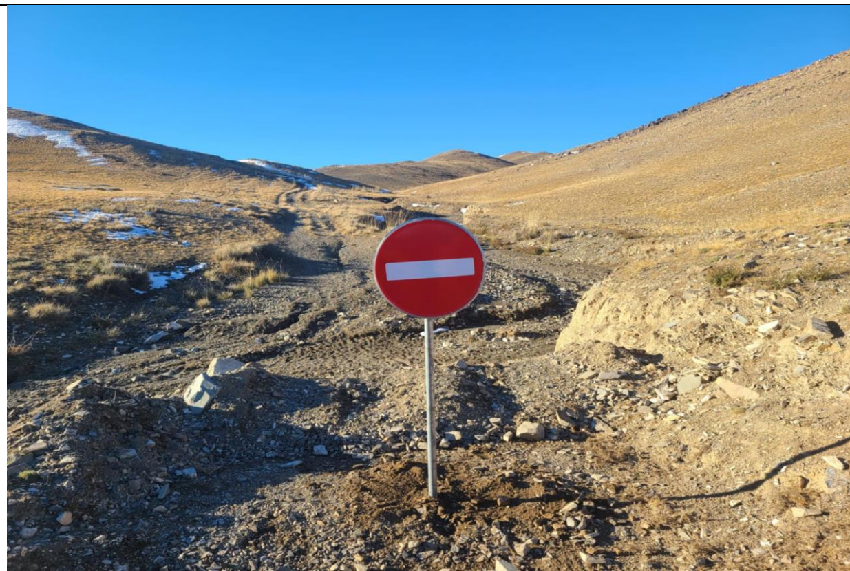
Зураг 48. Хуучин ашиглагдахгүй болсон замыг тэмдэгжүүлж хаалт хийсэн байдал
