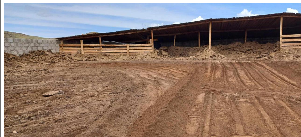
Зураг 147. Батзаяагийн өвөлжөөний хүрзэнг янзалж байгаа үе
