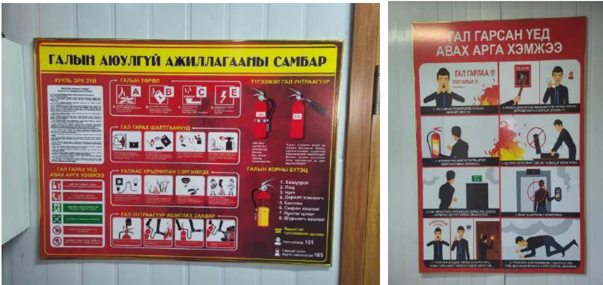
Зураг 7.2 Галын хор оффис, засварын газруудад байршуулсан байдал
