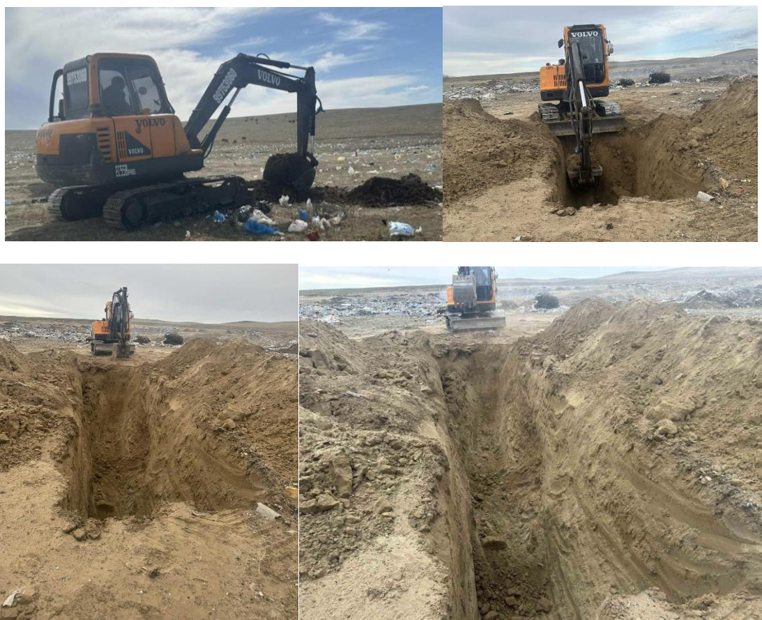
Зураг 36 Сэг зэм устгах нүх ухсан байдал
