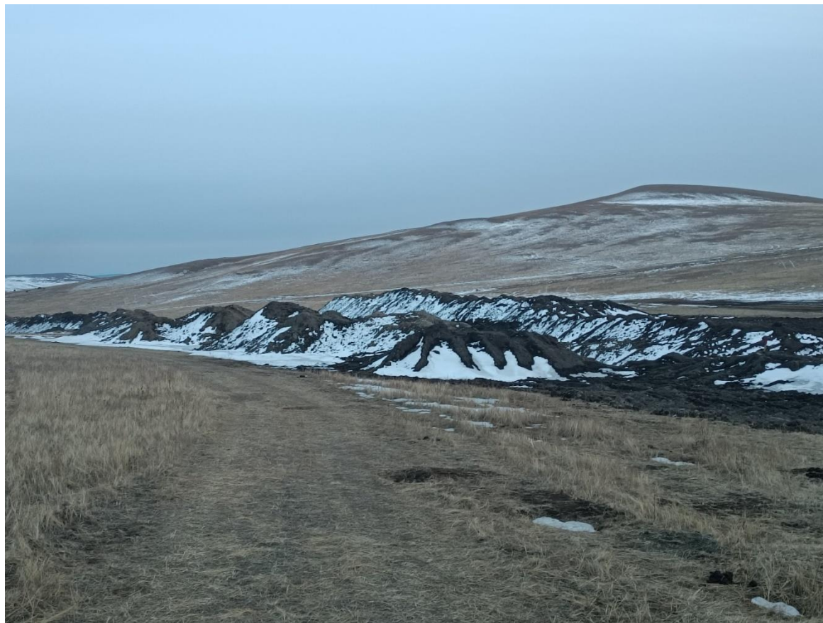
Зураг-14. Шимт хөрсний овоолго үүсгэсэн байдал
