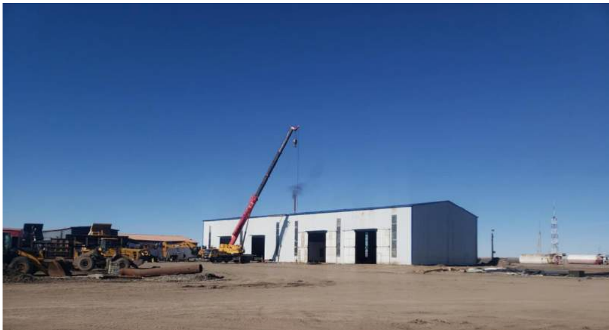
Зураг 2-10. Шинээр баригдаж буй засварын барилга
