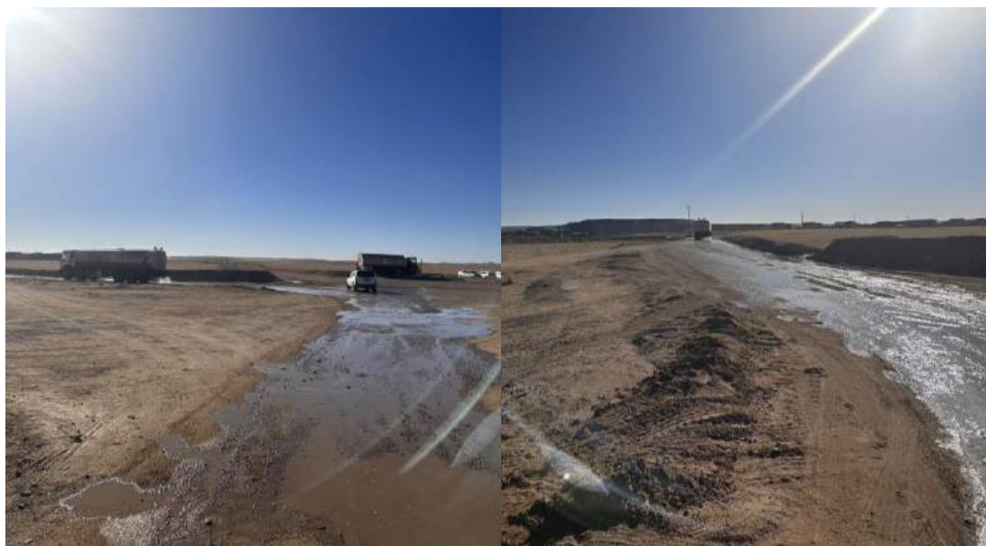
Зураг 2-8. Усалгаа хийж буй байдал
