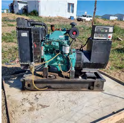
Дизель генераторын суурийг хатуу хучилттай болгосон нь
