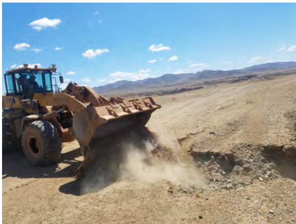
Эвдэрсэн зам засаж буй нь
