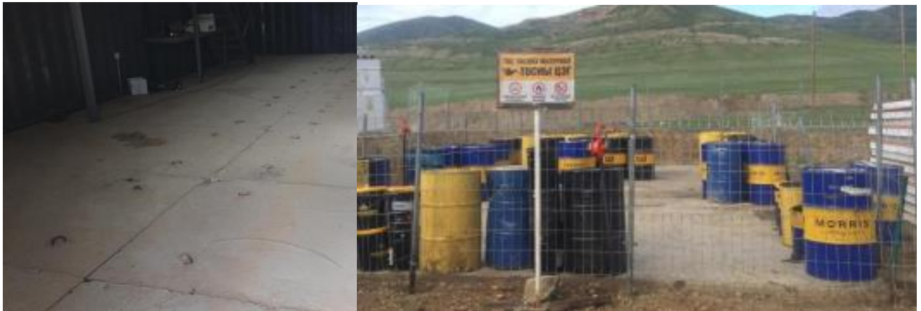
Зураг.4 Зөөврийн бетонон хавтангаар засварын талбайг, мөн хаягдал тосны цэгийг цементэн суурьтай болгон ажиллав
