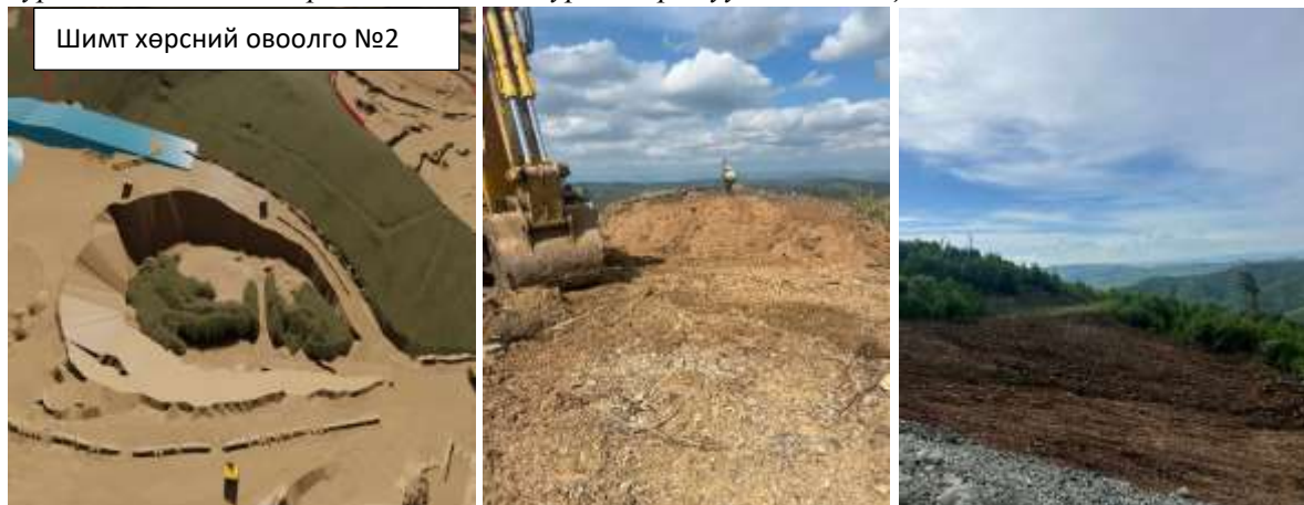
Зураг 2.12: Шимт хөрсний овоолгын зураг, хөрс хуулалтын явц
