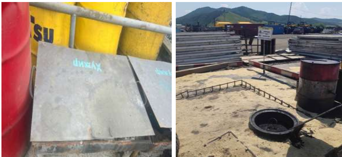
Зураг 2.10: Саармагжуулах хужир байршуулж үртэс дэвссэн зураг
