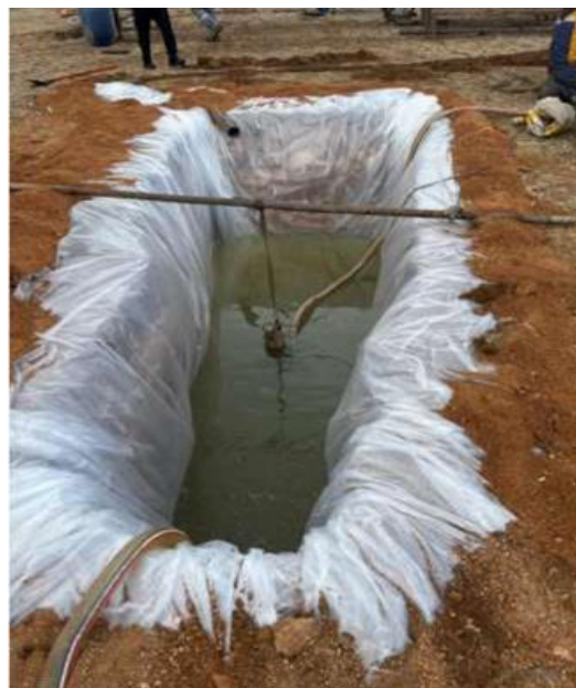
ЗУРАГ 9 ӨРӨМДЛӨГИЙН ШИНГЭН ХАДГАЛАХ САН , ХАМГААЛАЛТЫН ПЛАСТИК УУТ ДЭВССЭН БАЙДАЛ
