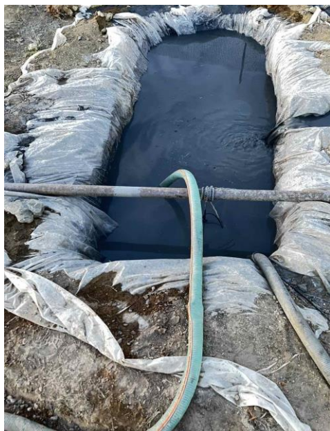
ЗУРАГ 9 ӨРӨМДЛӨГИЙН ШИНГЭН ХАДГАЛАХ САН , ХАМГААЛАЛТЫН ПЛАСТИК УУТ ДЭВССЭН БАЙДАЛ
