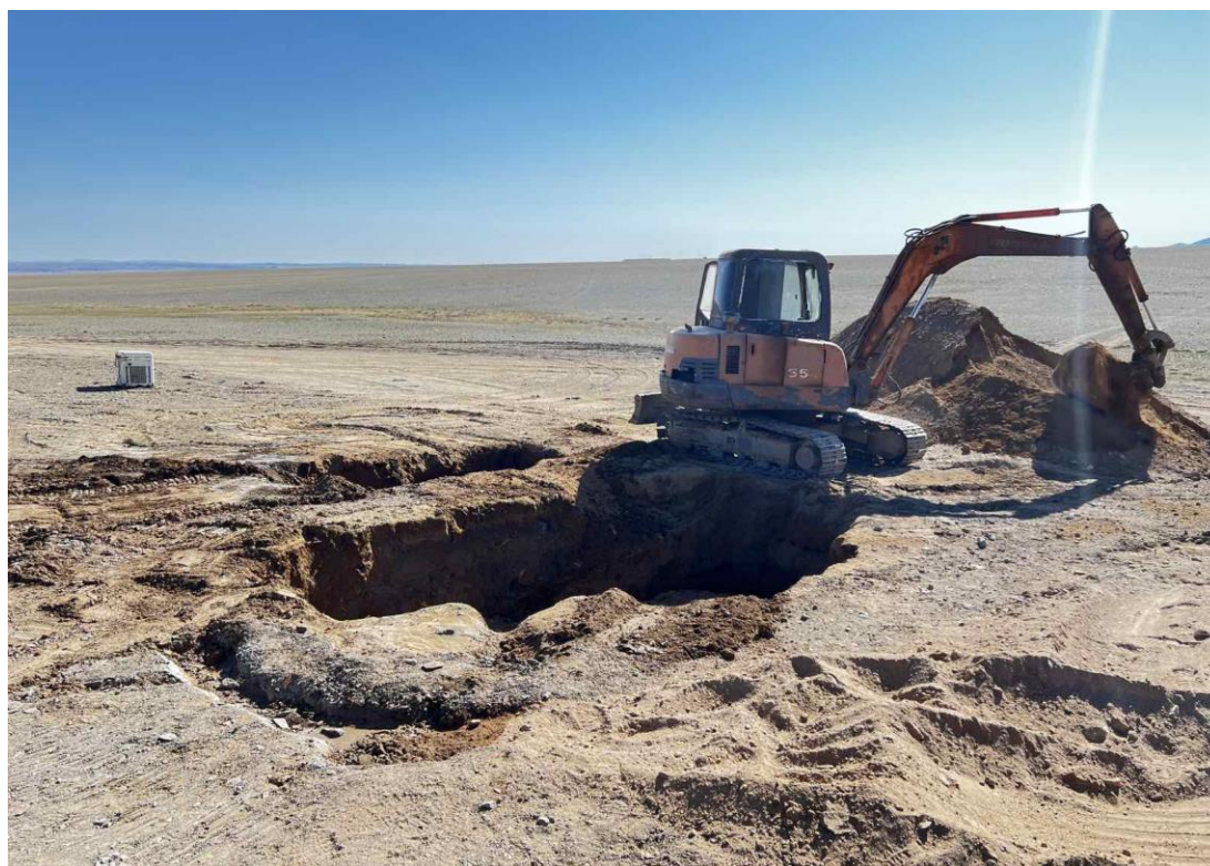
ЗУРАГ 10 ТЕХНИКИЙН НӨХӨН СЭРГЭЭЛТ ХИЙГДЭЖ БУЙ БАЙДАЛ
