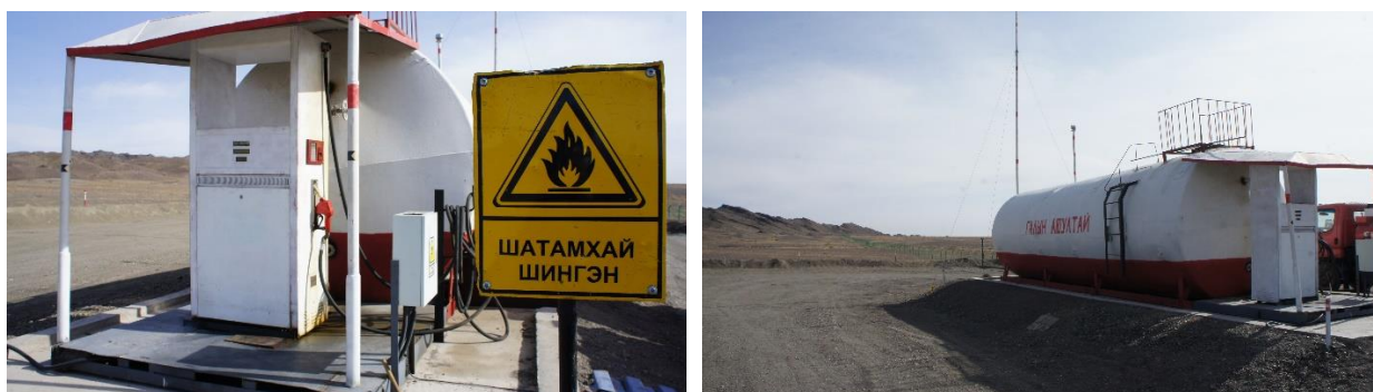
Зураг 8. Шатахуун түгээх станцын байгууламж
