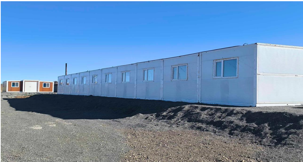
Зураг 5. Ажилчдын шинэ сууц
