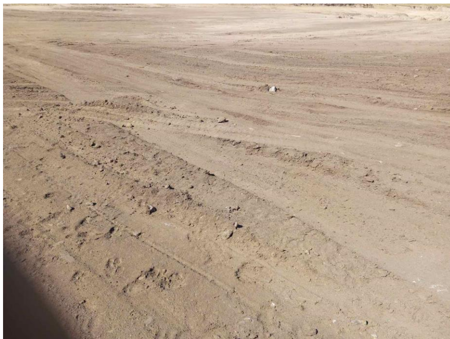
Зураг 12. дотоод овоолгоор нөхөн дүүргэлт хийж, хэлбэршүүлэн байдал
