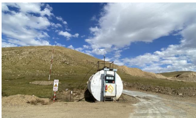
Зураг 10. Шатхуун түгээх станцын машин зогсох хэсгийг хатуу хучилттай болгосон байдал.
