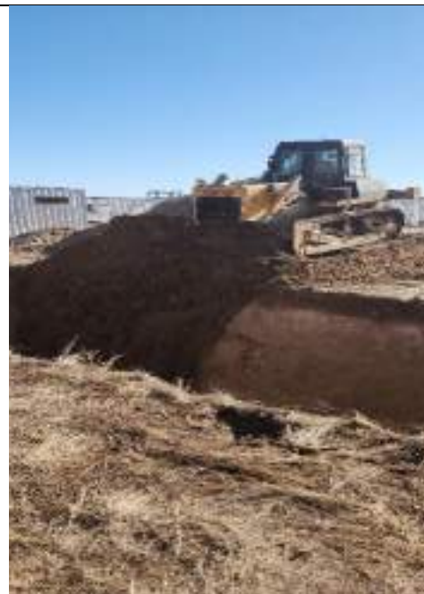
Ахуйн шингэн хаягдлын танк суурилуулсан нүхийг эргүүлэн булж дүүргэсэн.
