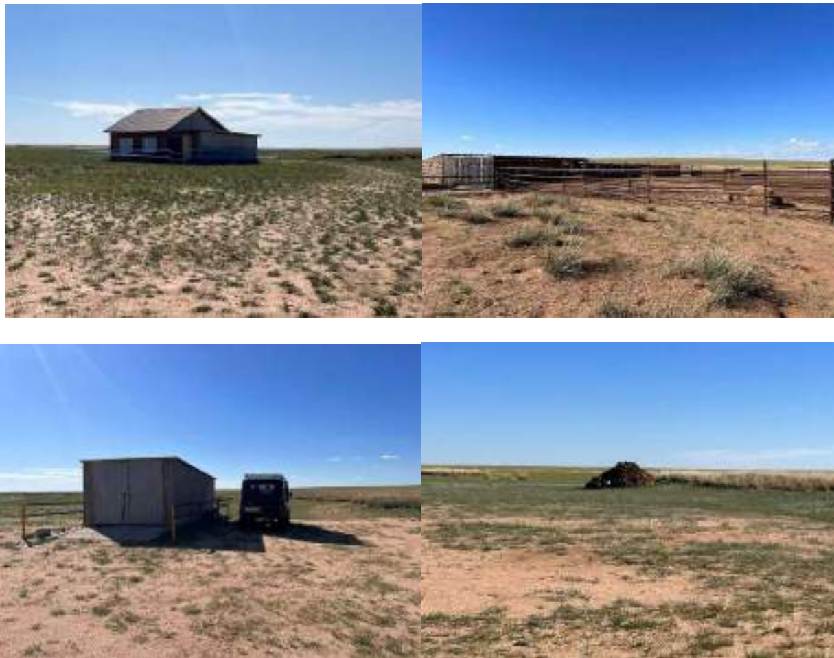
Зураг 71. Төслийн талбай дотор талбайн зүүн урд хэсэгт байрлах айл
