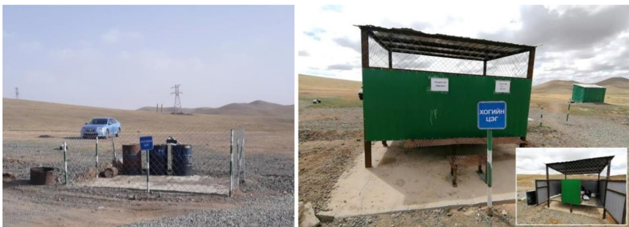
Зураг 27 . Энгийн хог хаягдал түр хадгалах бункер
