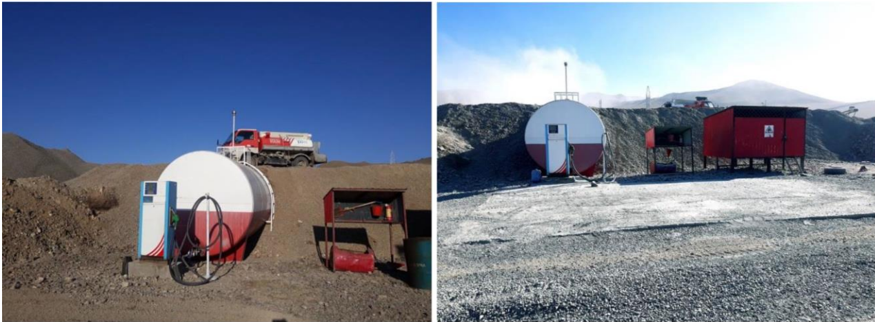
Зураг 4. ШТС-ийн талбай орчмыг бетондсон байдал
