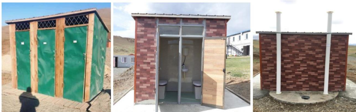
Зураг 26 . Нүхэн жорлонг халж, М 8 5924:2015 стандартын шаардлагад нийцсэн нүхэн жорлонг байршуулан ажиллаж байна.
