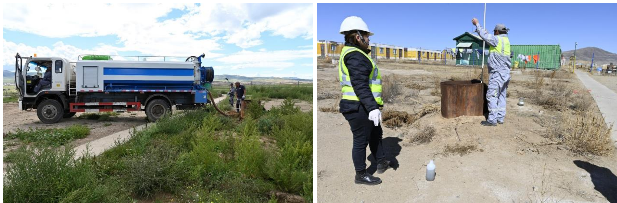
Зураг № 2.9. Бохир ус соруулж буй байдал.
