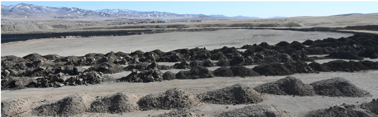
Зураг № 2.5. Техникийн нөхөн сэргээлт хийгдэж буй байдал.
