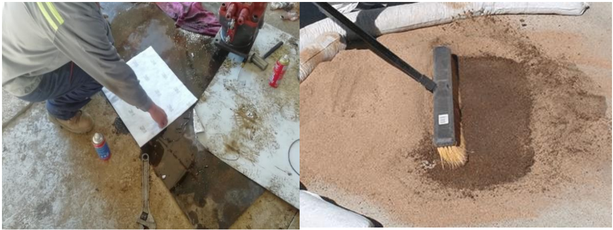
Зураг.11 Нефтийн бүтээгдэхүүн асгарсан тохиолдолд авах арга хэмжээ, Spill kit / Асгаралт шингээгч
