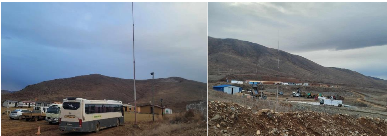
Зураг.33 ШТС болон кемпэд аянга зайлуулагч байрлуулсан
