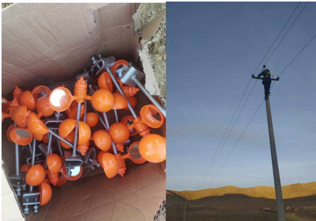
Зураг.16 Уурхайд байрлах нийт 10 ширхэг тулгуур дээр шувуу үргээгч суурилууллаа.
