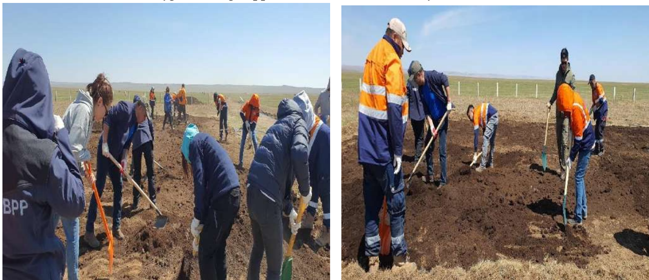
Зураг-10. Үржүүлгийн талбай бэлдэж буй байдал.
