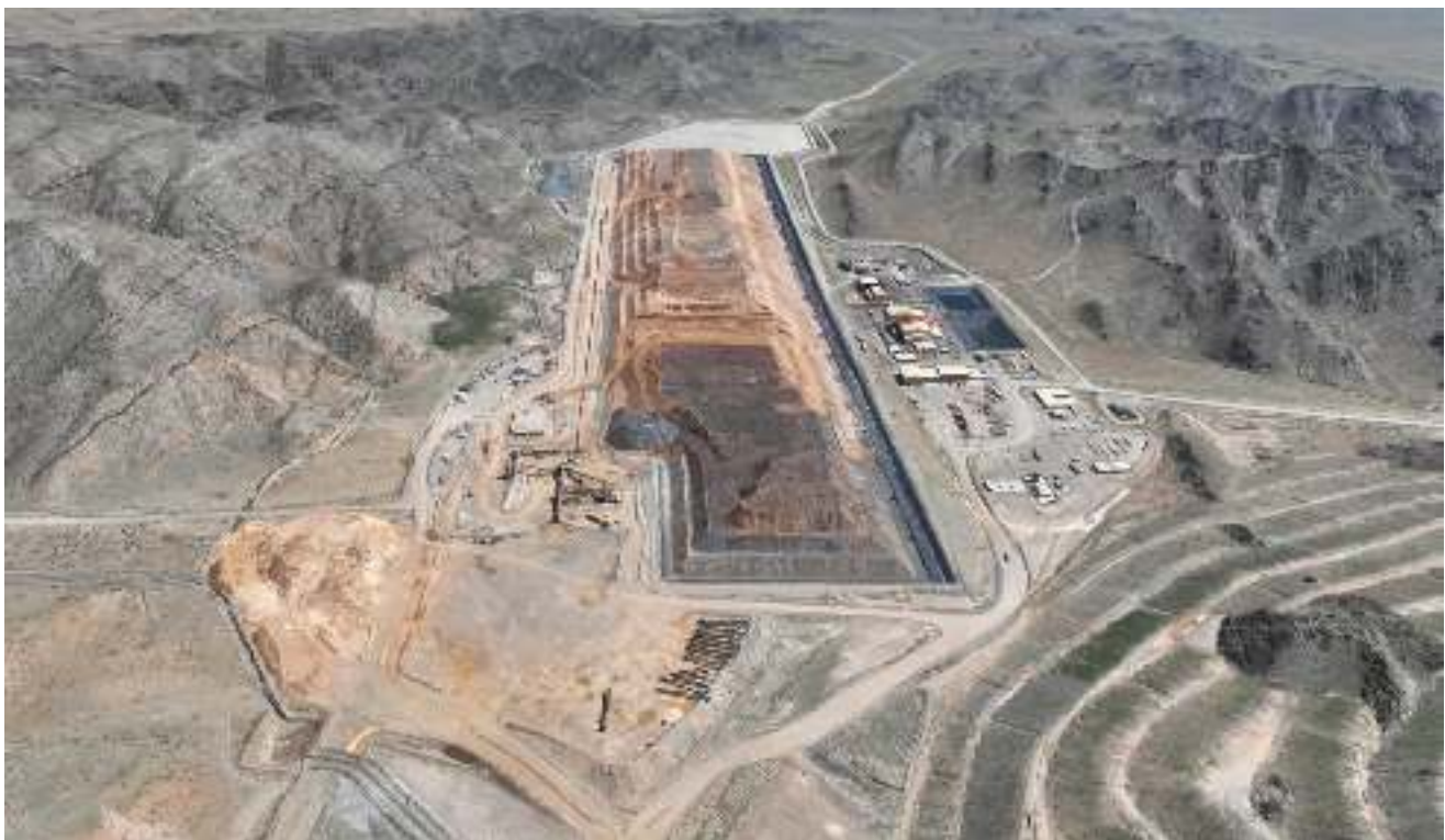
НУТ-н үерийн далан болон уусмал цуглуулах хайрцаг, уусмал дамжуулах хоолойн бүрэн бүтэн байдалд өдөр тутмын хяналтын зургаас
