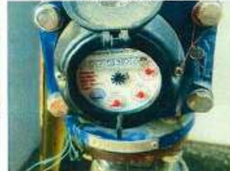
Үйлдвэрийн уурьт зуухны цоргын тоолуур /Зем усалгаа, нөхөн сэргээлт/ - 25302
