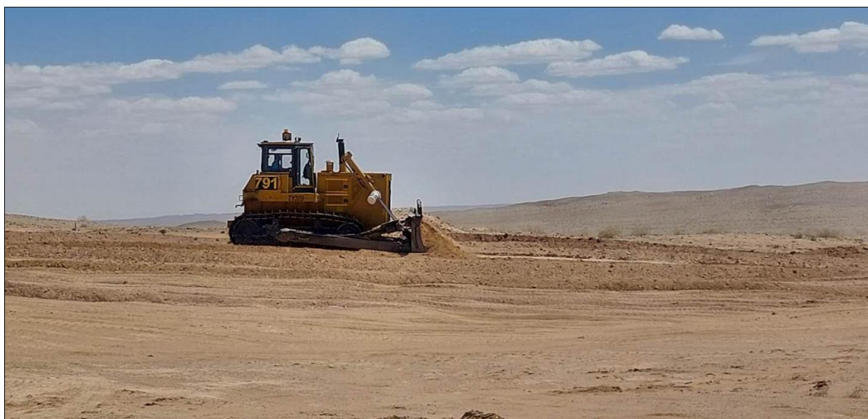
Зураг № 25. Уурхайн технологийн замын шимт хөрс хуулалт
