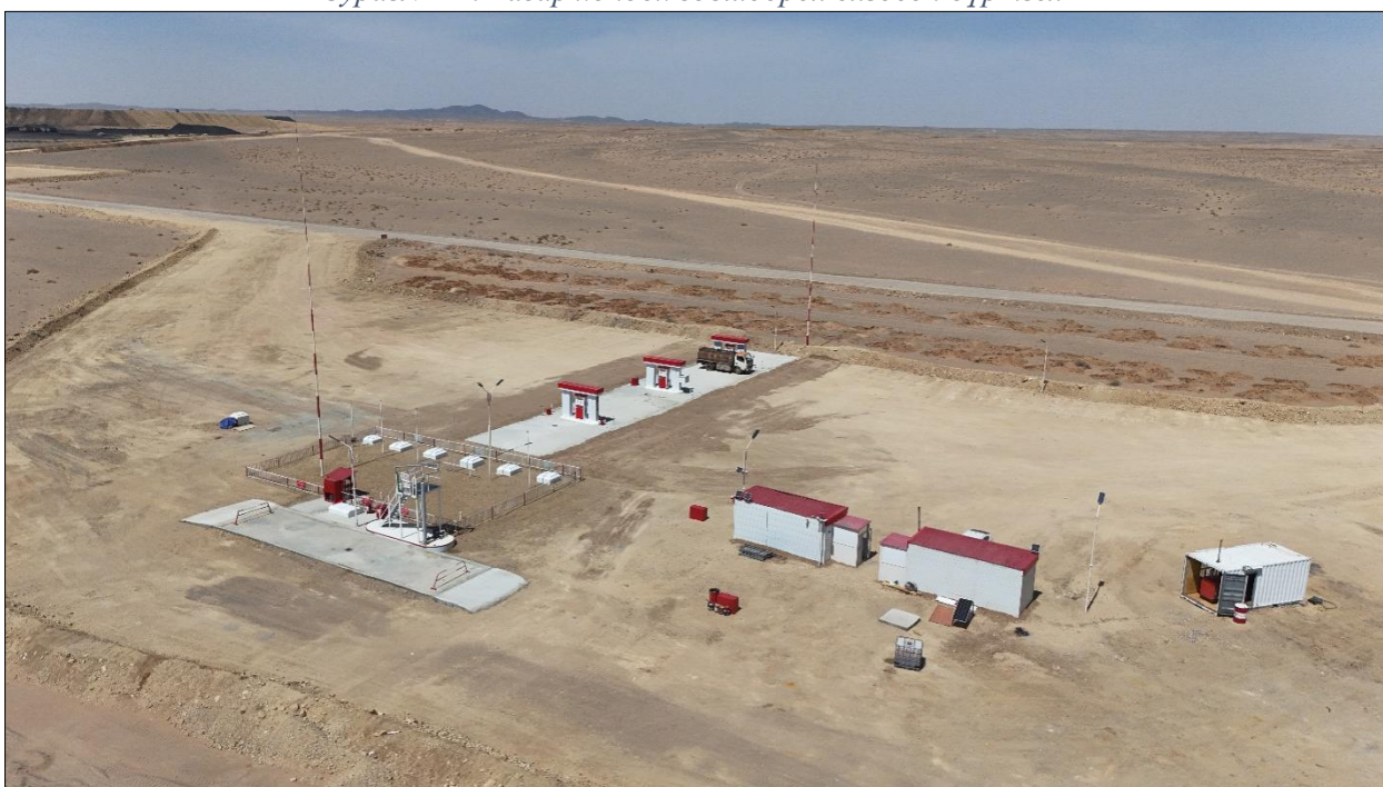
Зураг№ 18. Засварын газар, ШТС, Шатах тослох материалын агуулах хөрс бохирдохоос сэргийлж цементэн хучилттай болгосн байдал
