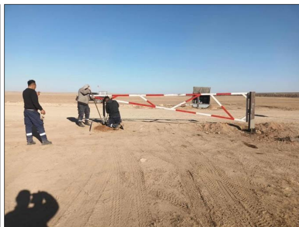
Зураг№ 41. Төмөр замын гарам дээр хаалт хийж машин техникийн аюулгүй байдлыг хангасан байдал
