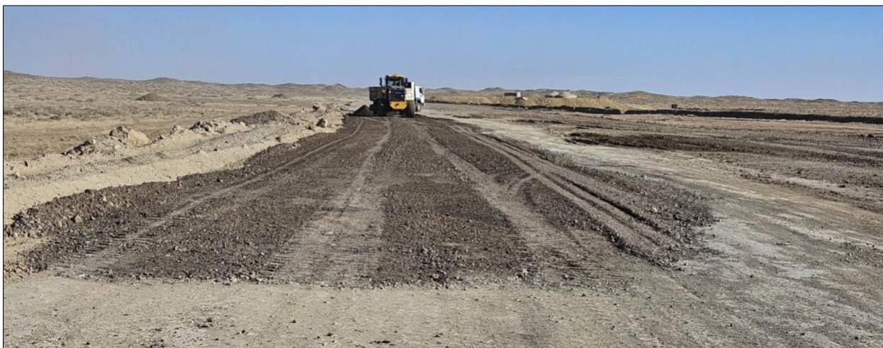
Зураг№ 10. Тоосжилтыг бууруулах 1 км замын туршилтын ажил
