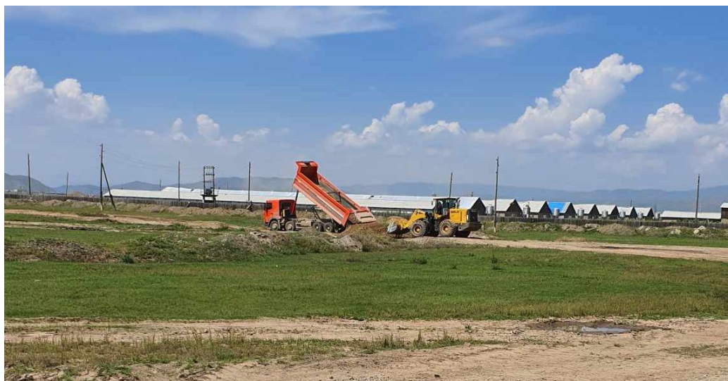
Зураг 3. Орчны сөрөг нөлөөллийг бууруулах ажлын хүрээнд тээврийн хэрэгсэл явах карьерийн зам дээр хайрга асгаж тэгшилэх ажилын явц
