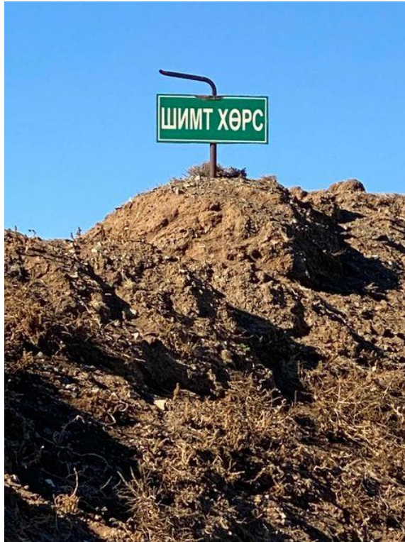
Зураг 5. Төслийн талбайд хийгдсэн шимт хөрс овоолго
