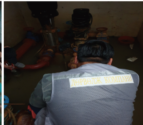
Тоолуурыг суурилуулж буй байдал
