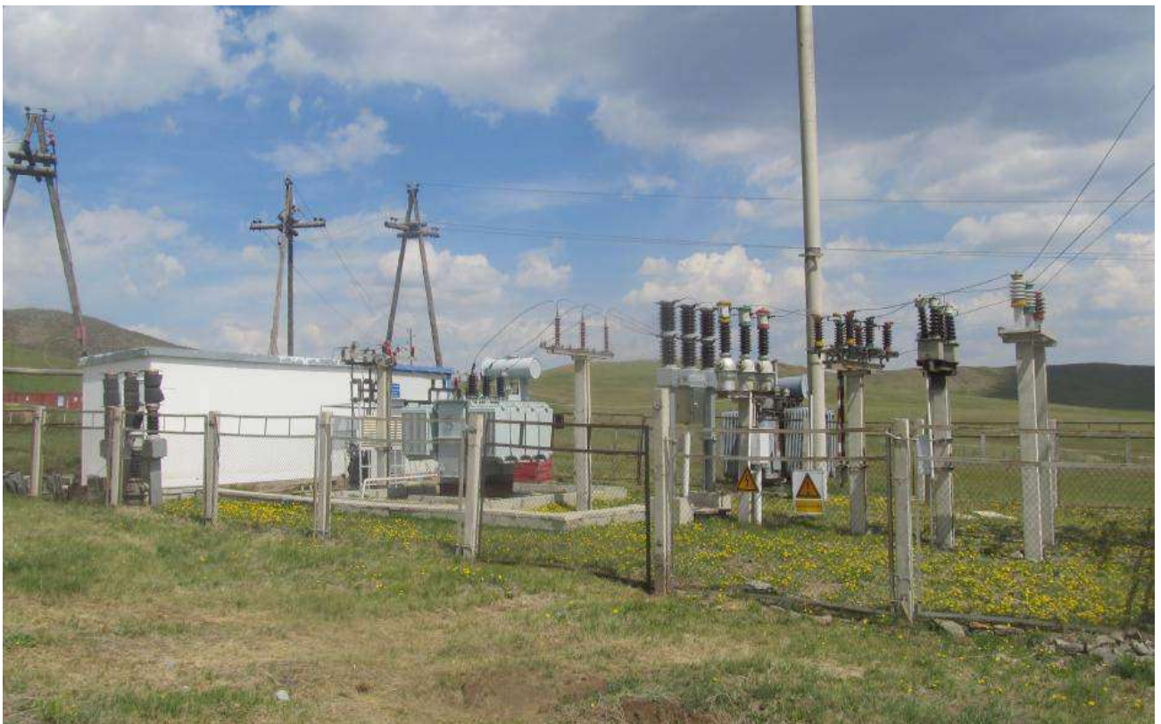
Зураг 10. Уурхайн дэд станц оролтын шугамын хүчин чадал (35000V)
