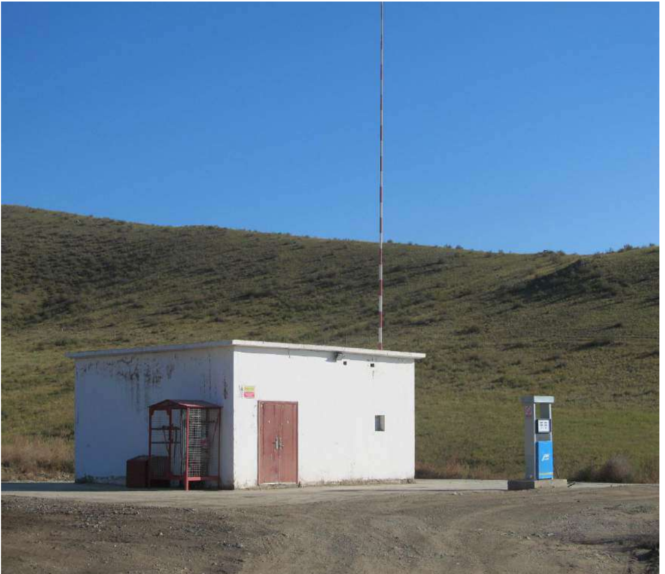
Зураг 18. Шатахуун түгээх станц
