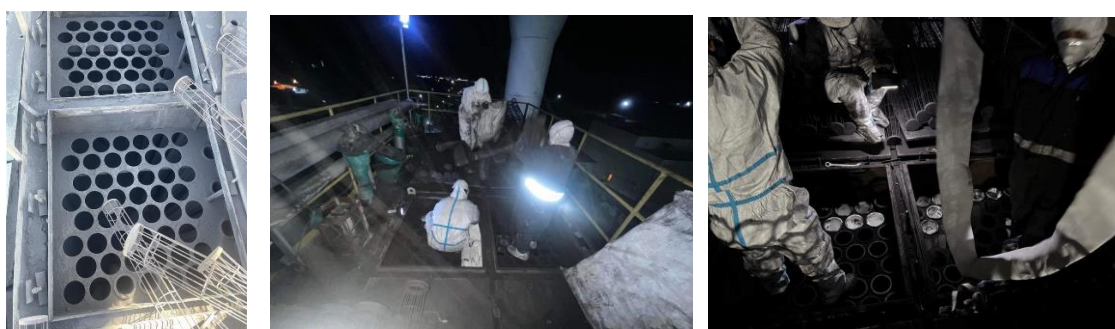
Зураг 3. Талбайн дамжлага бүрийн фильтерийн үзлэг хяналтын ажлын явц
