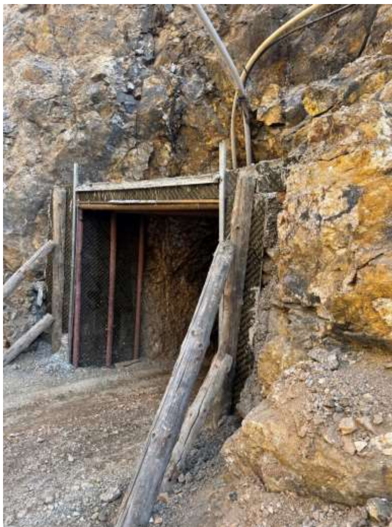
Зураг 10. Уурхайн талбайд явагдаж байгаа хайгуулын ажлын налуу амны бэхэлгээ хийсэн байдал
