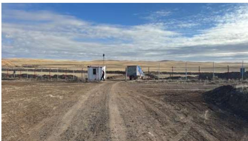
Зураг 7. Уурхайн гол замуудыг шинээр тавьж, уулзвар бүрт тэмдэг тэмдэглэгээ байрлуулсан байдал
