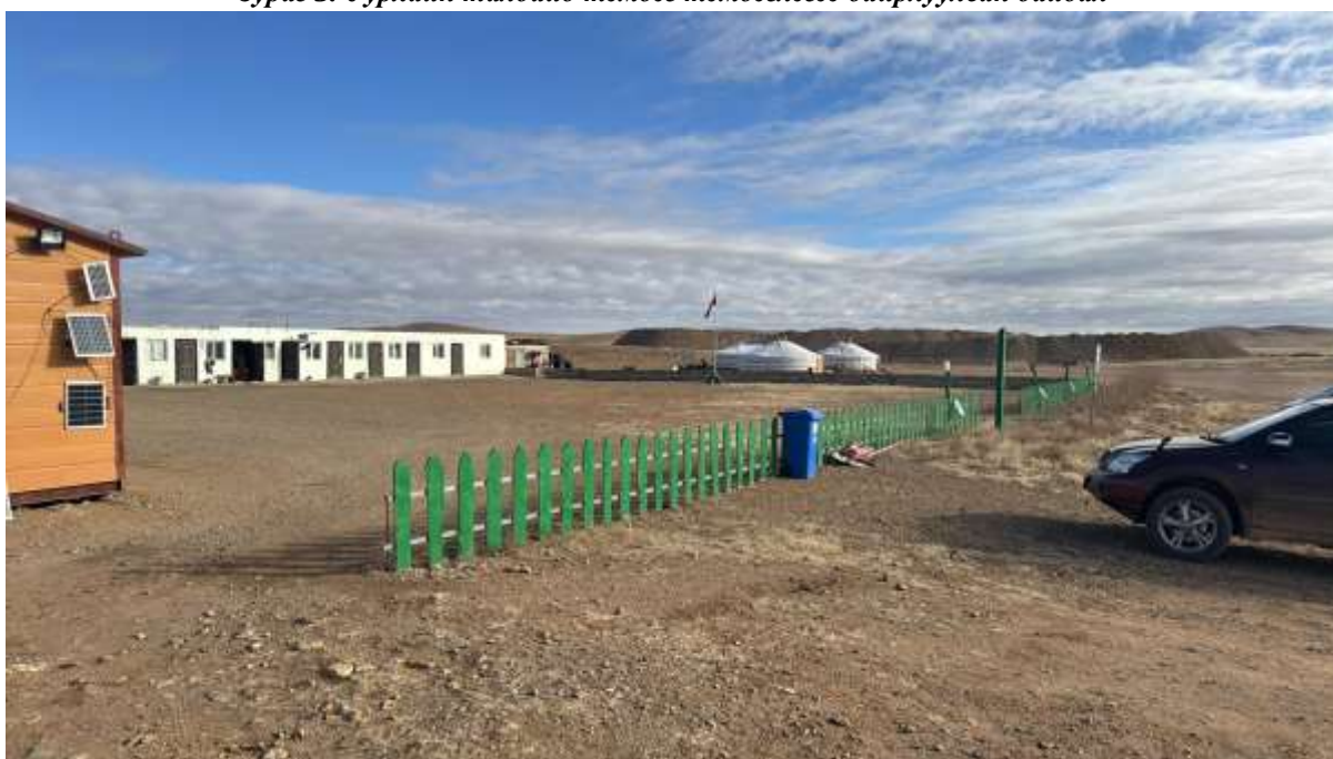
Зураг 4. Ажилчдын кемпийн тохижилтын ажлыг бүрэн хийж гүйцэтгэсэн байдал
