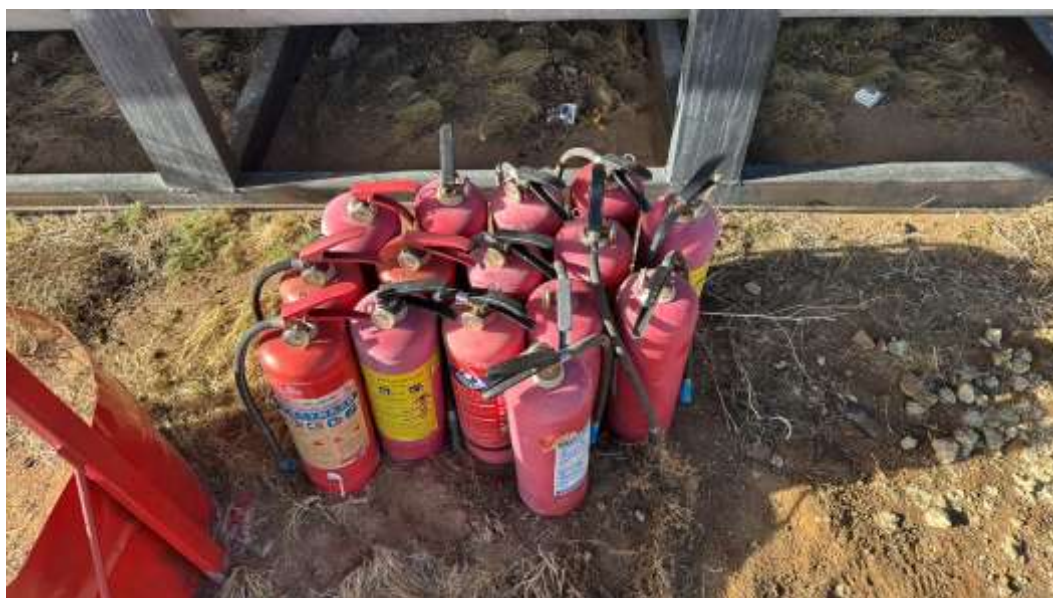
Зураг 31. Шатахуун түгээгүүрийг засч тохижуулж, галын хорыг шинэчилсэн байдал
