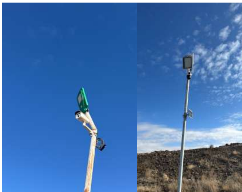
Зураг 9. Уурхайн шалган нэвтрүүлэх постыг шинээр тохижуулж, камержуулсан байдал
