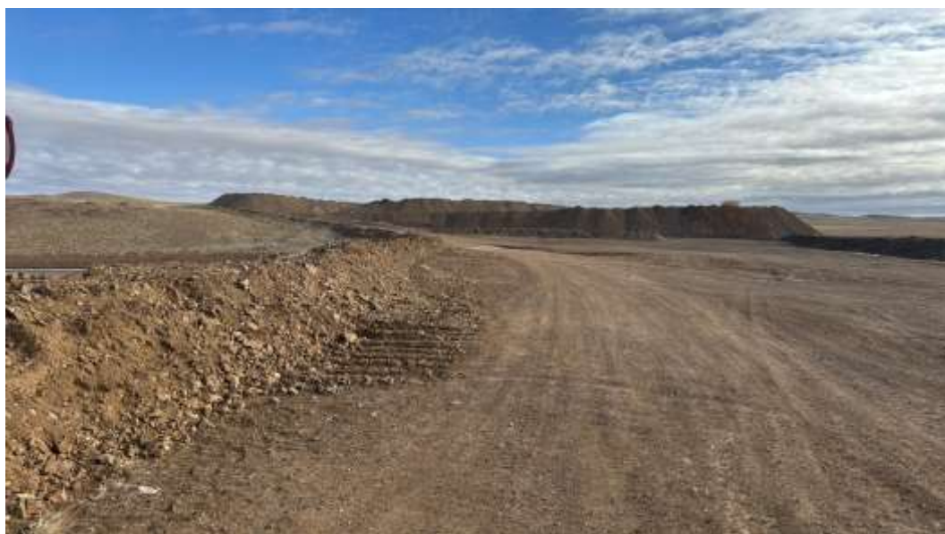
Зураг 6. Уурхайн замын далан шуудууг сэргээн засварласан байдал
