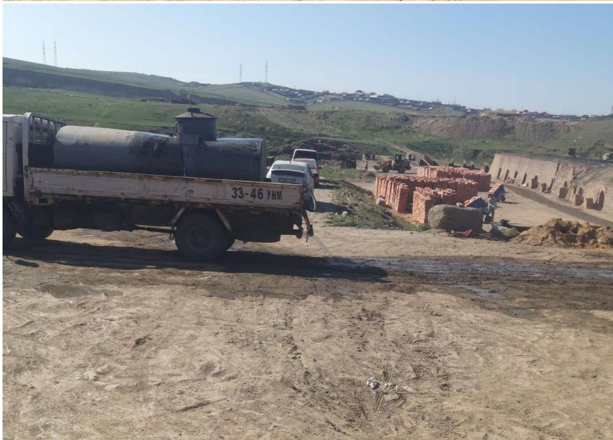
Зураг 1. Замын тоосжилт дарах зорилгоор замын усалгаа хийжэ буй байдал
