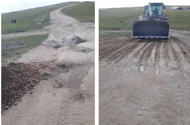
Зураг 2. Зам талбайг засаж буй байдал
