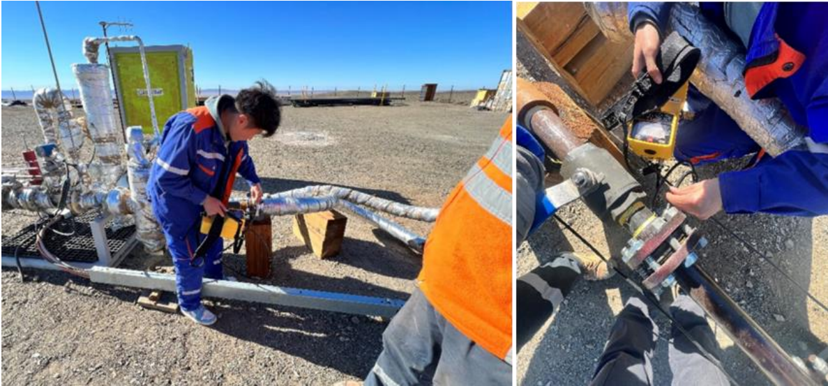
Фото зураг 4. Хийн алдагдлаас сэргийлж хэмжилт хийж буй байдал
