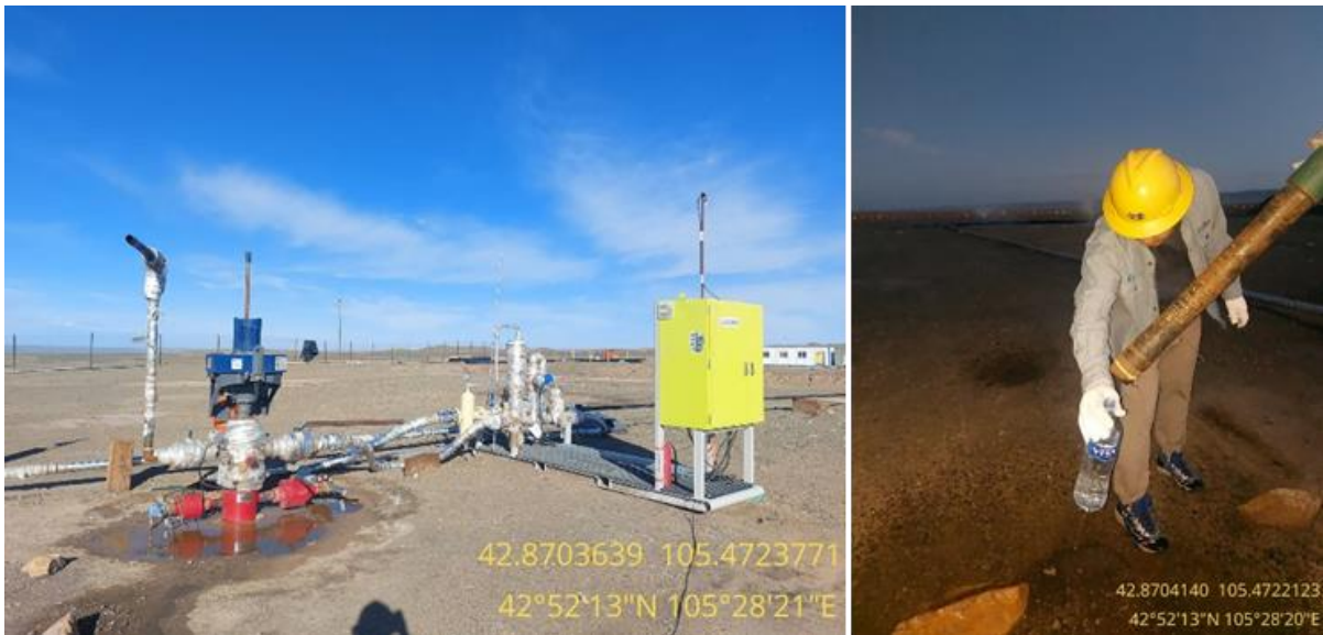
Фото зураг 44. Номгон – 10 цооногоос усны дээж авч буй байдал
