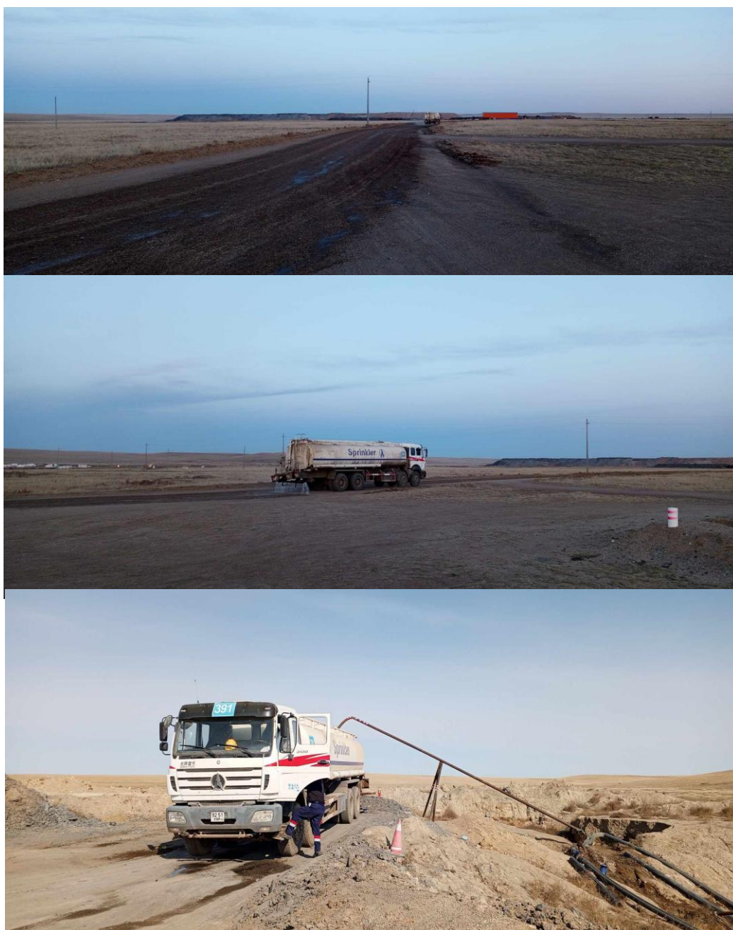
Зураг11. Усалгаа хийж буй байдал
