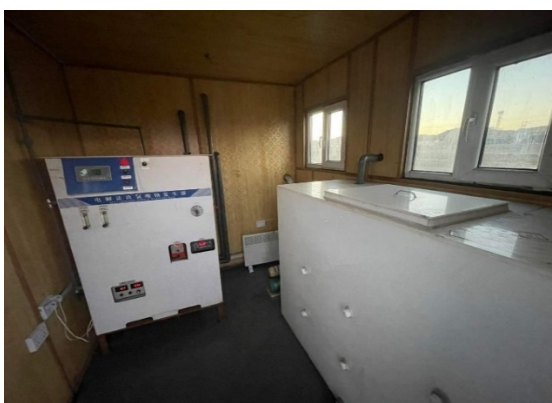
Зураг 4.4.5 Ахуйн хаягдал ус цэвэрлэх байгууламж болон хаягдал ус хуримтлуулах сан
