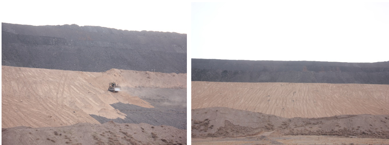
Зураг 5.3.1. Хаягдлын овоолгын хэлбэршүүлсэн талбай дээр шимт хөрсийн хучилт хийж буй байдал
