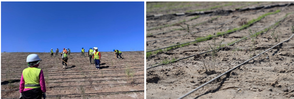
Зураг 5.4.1. Шимт хөрсөөр хучилт хийж буй байдал, биологийн 1-р шатны нөхөн сэргээлт
