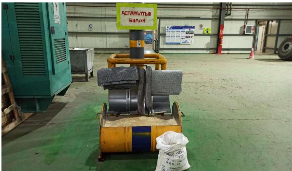
Зураг 10. Шатахуун түгээгүүр болон засварын газар асгаралтын иж бүрдлийг байршуулсан байдал
