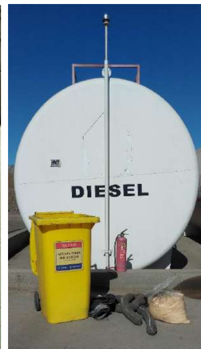
Зураг 10. Шатахуун түгээгүүр болон засварын газар асгаралтын иж бүрдлийг байршуулсан байдал
