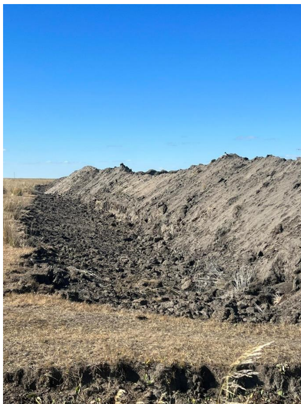
Зураг 16. Үерээс хамгаалах далан шуудууг зассан байдал
