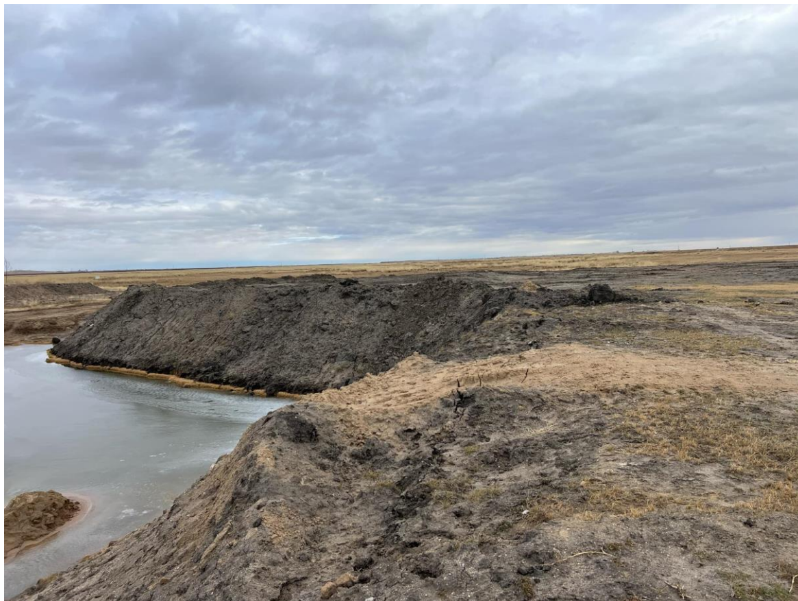
Зураг 8. Шимт хөрс болон хаягдал овоолгыг ашиглан нөхөн сэргээлт хийсэн байдал
