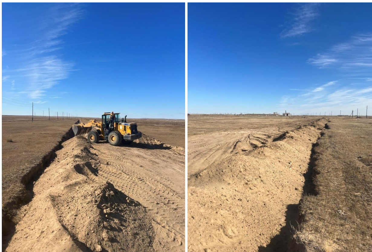
Зураг 11. Дүйцүүлэн хамгаалах арга хэмжээндий хүрээнд газрыг булж техникийн нөхөн сэргээлт хийсэн байдал
