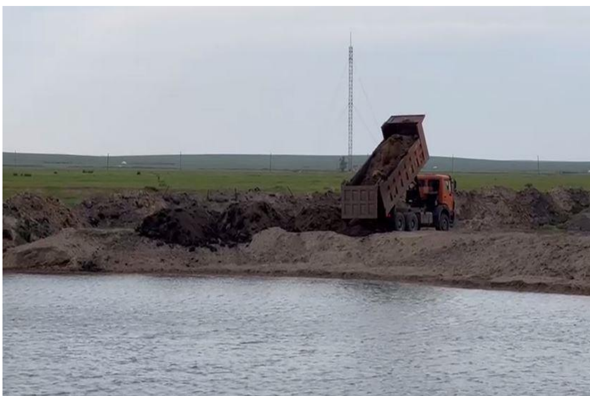
Зураг 9. Хиймэл нуурын эргэн тойронд хөрс асгаж, хөрсийг тэгшилж тохижуулсан байдал
