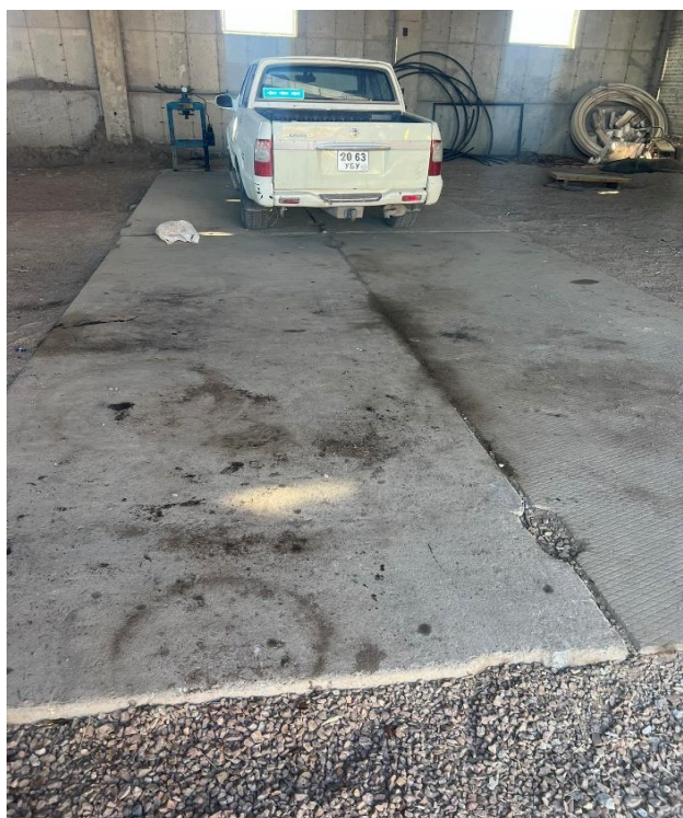
Зураг 21. ШТМ болон аюултай хог хаягдлыг хадгалах талбайг хатуу хучилттай болгосон байдал
