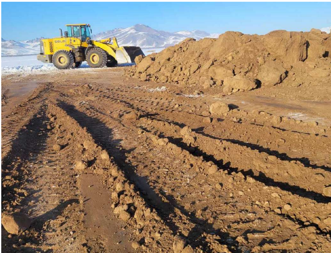
Зураг №8. Талбайд хойд хэсэгт хийгдэж байгаа техникийн нөхөн сэргээлт
