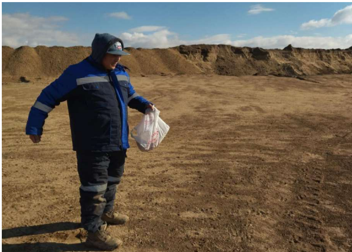
Зураг №6. Талбайд зүлэгний үр цацах үе
