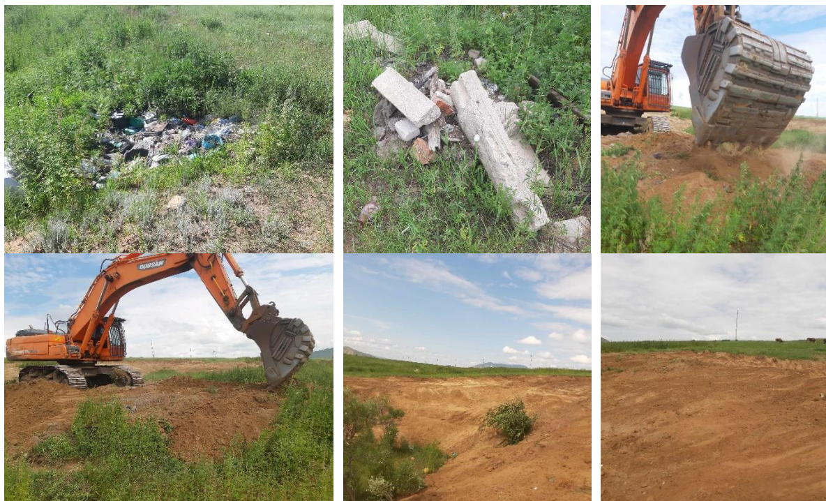
Зураг 2-10. Баян-Өлзийт сумын хуучин хогийн цэгийн 3 га талбайд техникийн нөхөн сэргээлт хийж буй байдал
