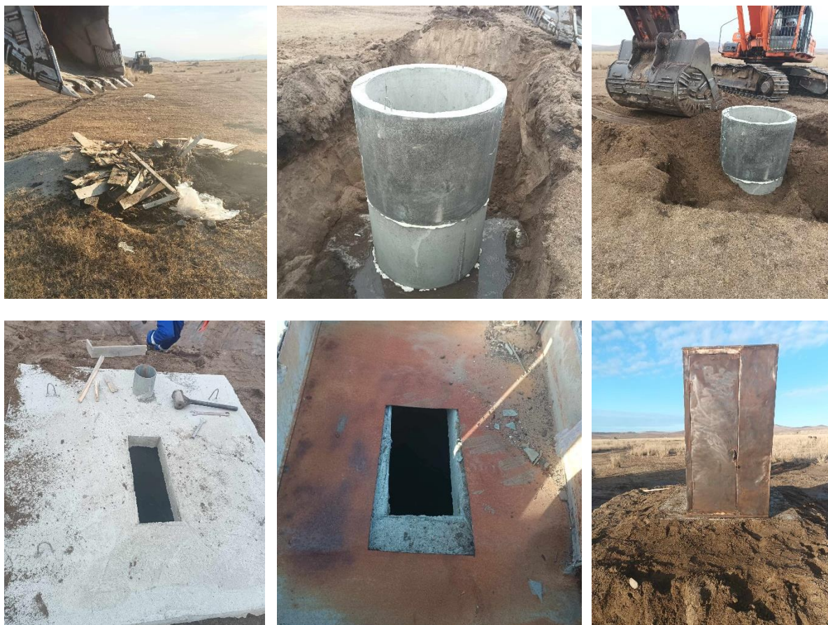
Зураг 2-7. Хуучин хэрэглэж байсан бие засах газрыг буулгаж, шинээр эко бие засах газар байгуулж буй байдал
