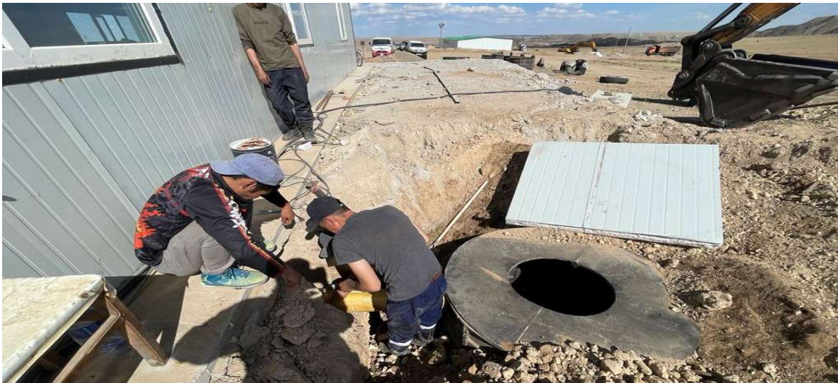
Зураг 23. Уурхайд 2024 онд шинээр хийгдсэн бохирын цооног
