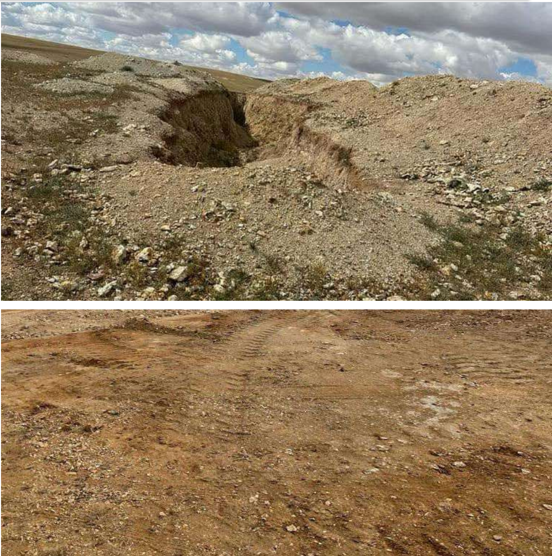
Зураг 40. Ухашиг нөхөн дүүргэлт хийж тэгшилж байгаа болон нөхөн сэргээлтийн ажлын дараа
