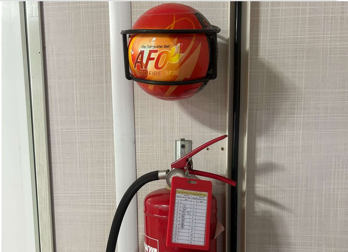
Зураг 43. Галын хорыг шинээр нэмж байршуулсанаас гадна хяналтын хуудастай болсон
