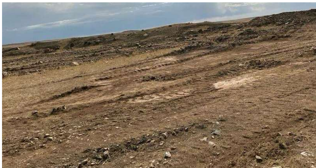
Зураг 39. Ухашыг нөхөн дүүргэлт хийж тэгшилж байгаа болон нөхөн сэргээлтийн ажлын дараа
