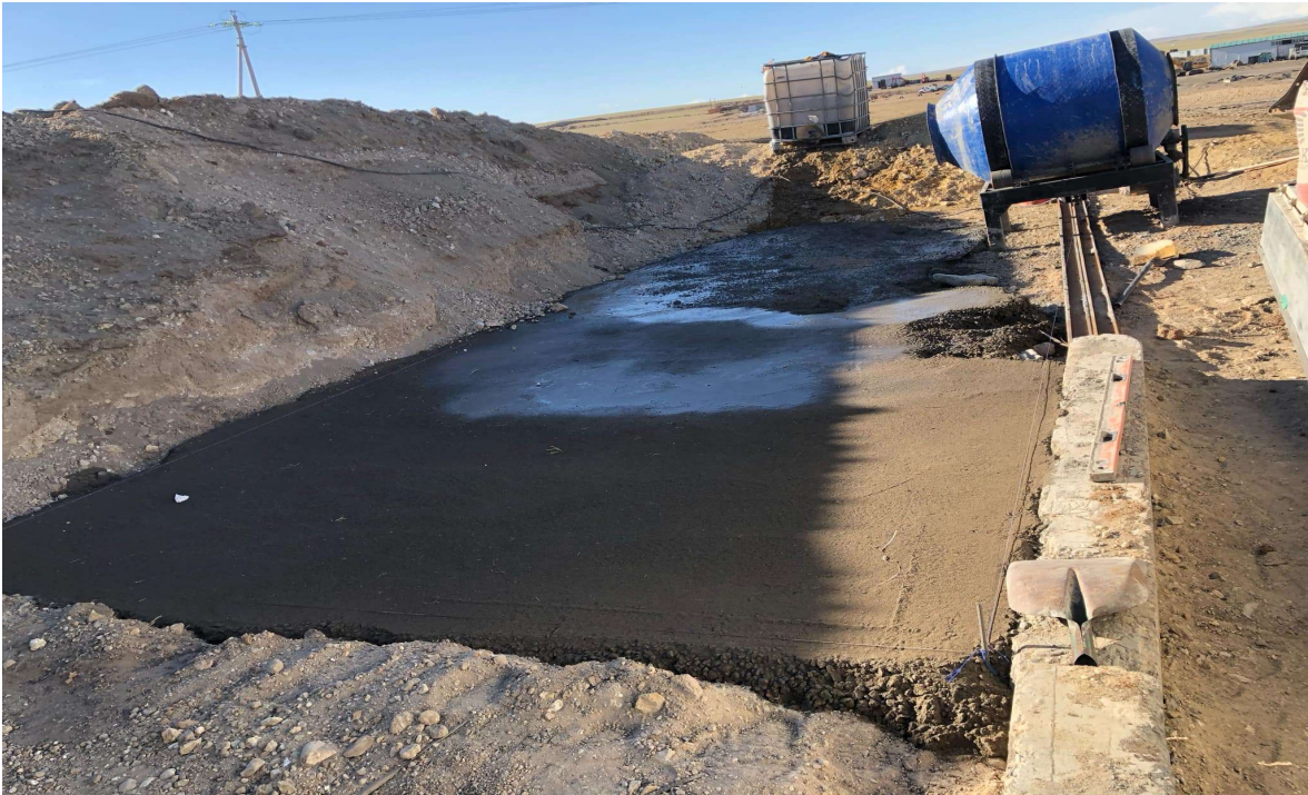
Зураг 14. ШТС-ын өргөтгөлийн суурийн талбайг бетонон хучилт хийж байгаа нь
