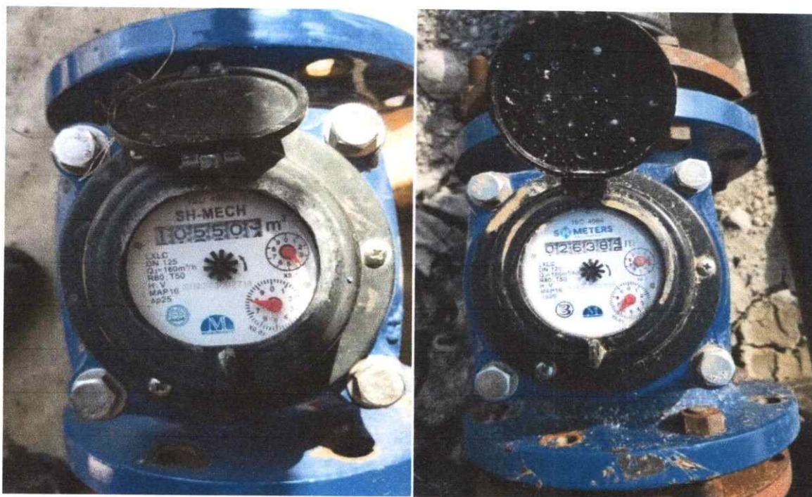
Зураг 5 Хүйтэн усны DN125 тоолуур суурьлуулсан байдал
