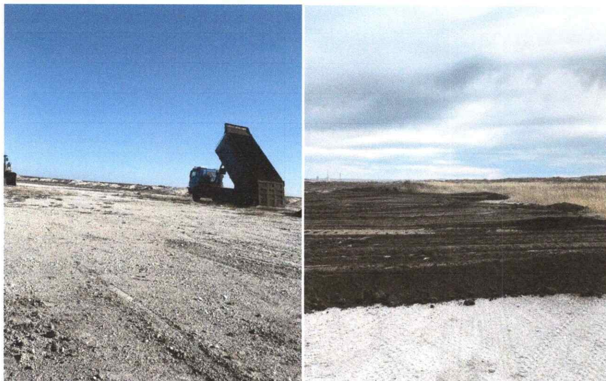
Зураг 12. 1 га талбайд шимт хөрс буулгаж тэгшилэх ажил
