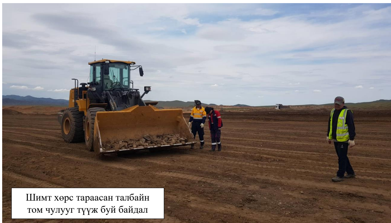
Зураг 27 Шимт хөрсний хучилтын ажил буюу Шимт хөрс дэвссэн байдал
