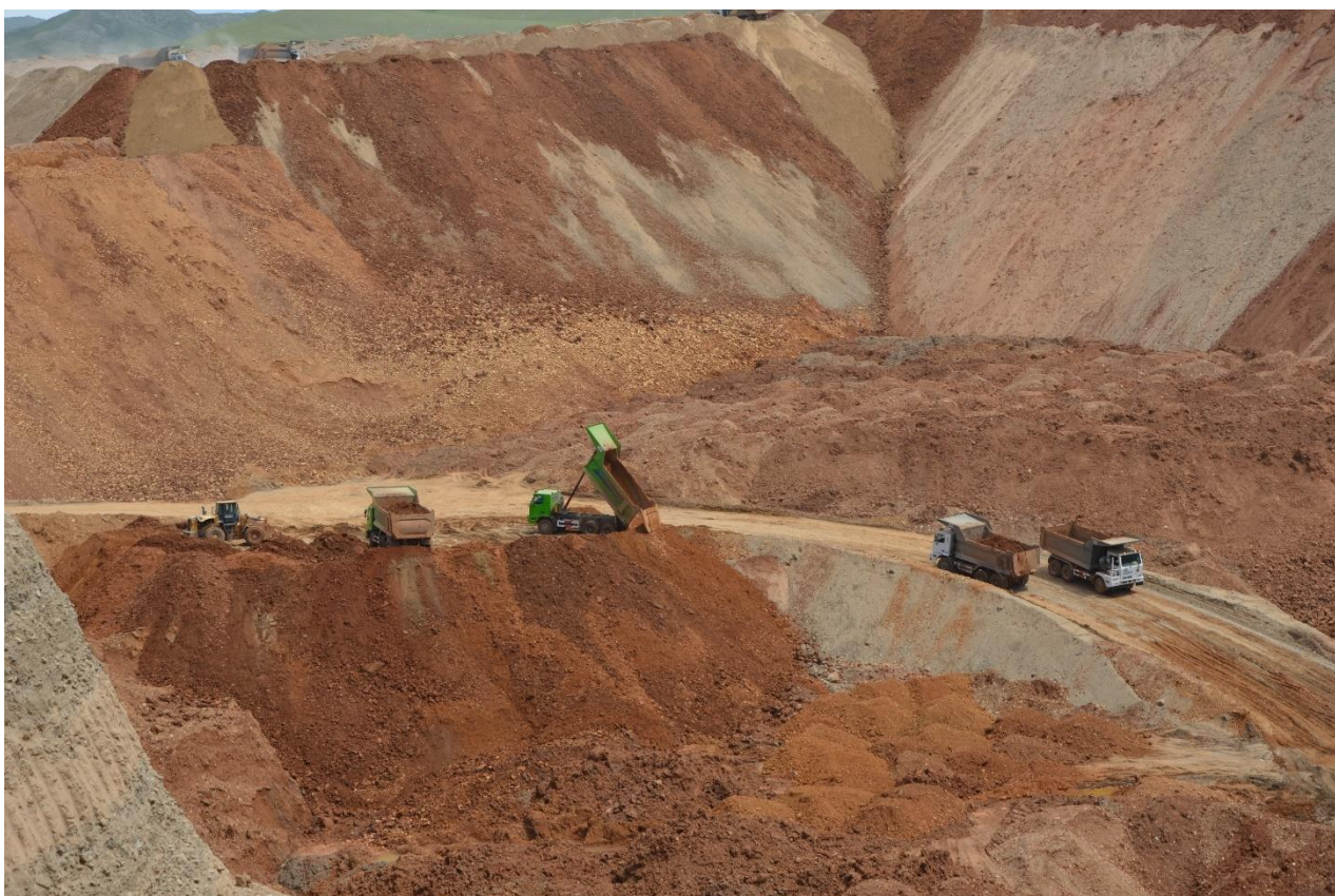
Зураг 25 Дотоод овоолго үүсгэх замаар нөхөн сэргээлтийн ажил хийгдэж буй байдал
