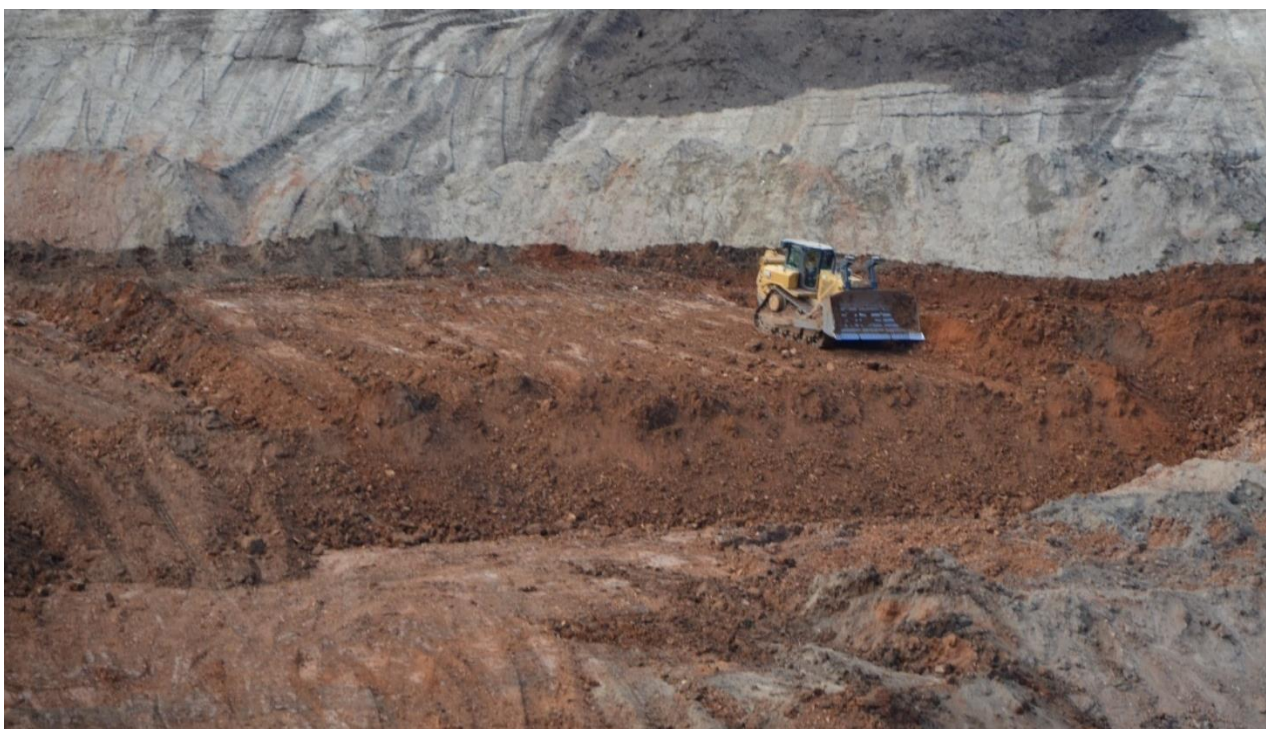
Зураг 26 Ухшийг дүүргэх, хурдас чулуулгийн овоолгыг намсгах, ирмэгийг налуулах, тэгшлэх, хэлбэршүүлэлтийн ажил явагдаж байна.
