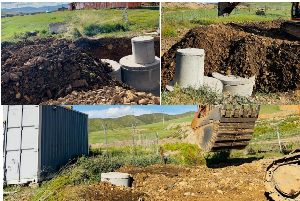
Зураг 36 Ахуйн шингэн хаягдалын танк суурьлуулалтын ажил
