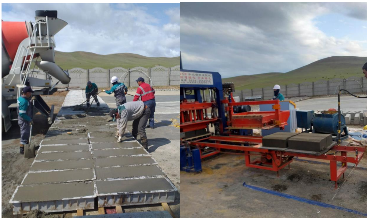
Зураг 4 Бетон боловсруулалтын явц
