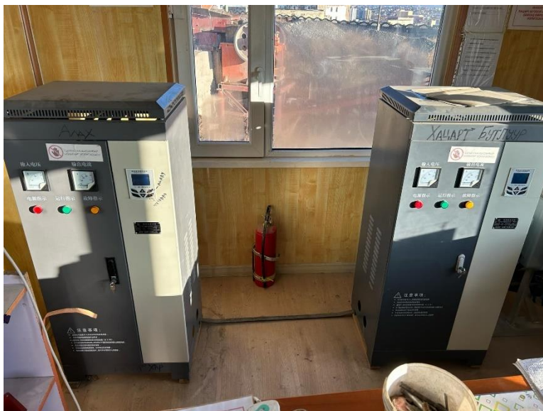
Зураг 37 Үйлдвэрийн талбай болон ажлын талбайнуудад галын хор байршуулсан
