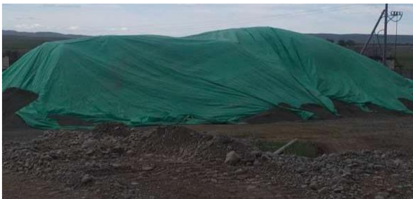
Зураг 10 Тоосжилтийг бууруулах зорилгоор хучилт хийж буй байдал
