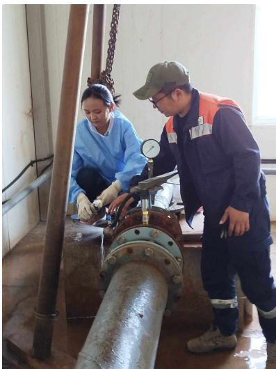
Зураг 6. Усны орд эх үүсвэрийн худгуудын цооногын түвшний хэмжилт, усны тоолуурын заалт авч буй байдал
