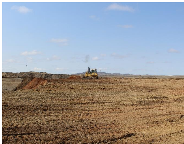
Зураг 13. Дотоод овоолго хэлбэржүүлж нөхөн дүүргэлт хийж буй байдал
