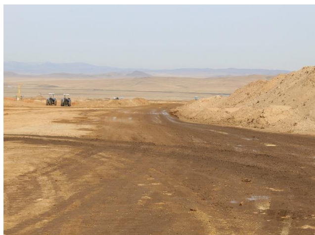
Зураг 15. Усалгааны машин зам талбай усалж буй байдал
