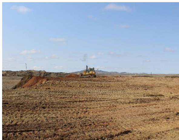
Зураг 19. Дотоод овоолго хэлбэржүүлж нөхөн дүүргэлт хийж буй байдал
