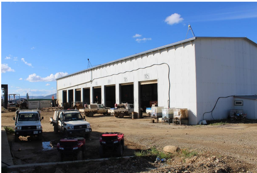
Зураг 4. Засварын цех
