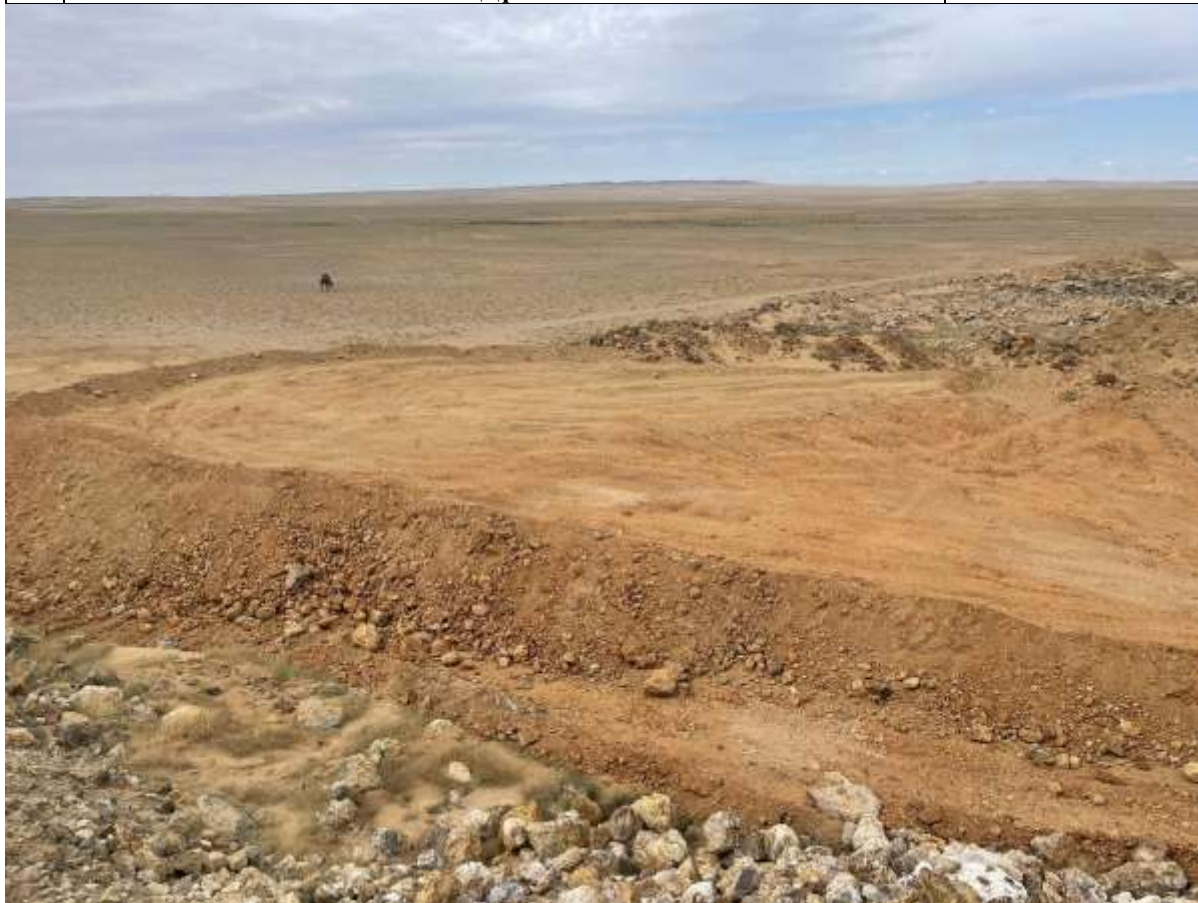
Зураг 7. Шимт хөрсний овоолгыг засч тэгшилсэн байдал
