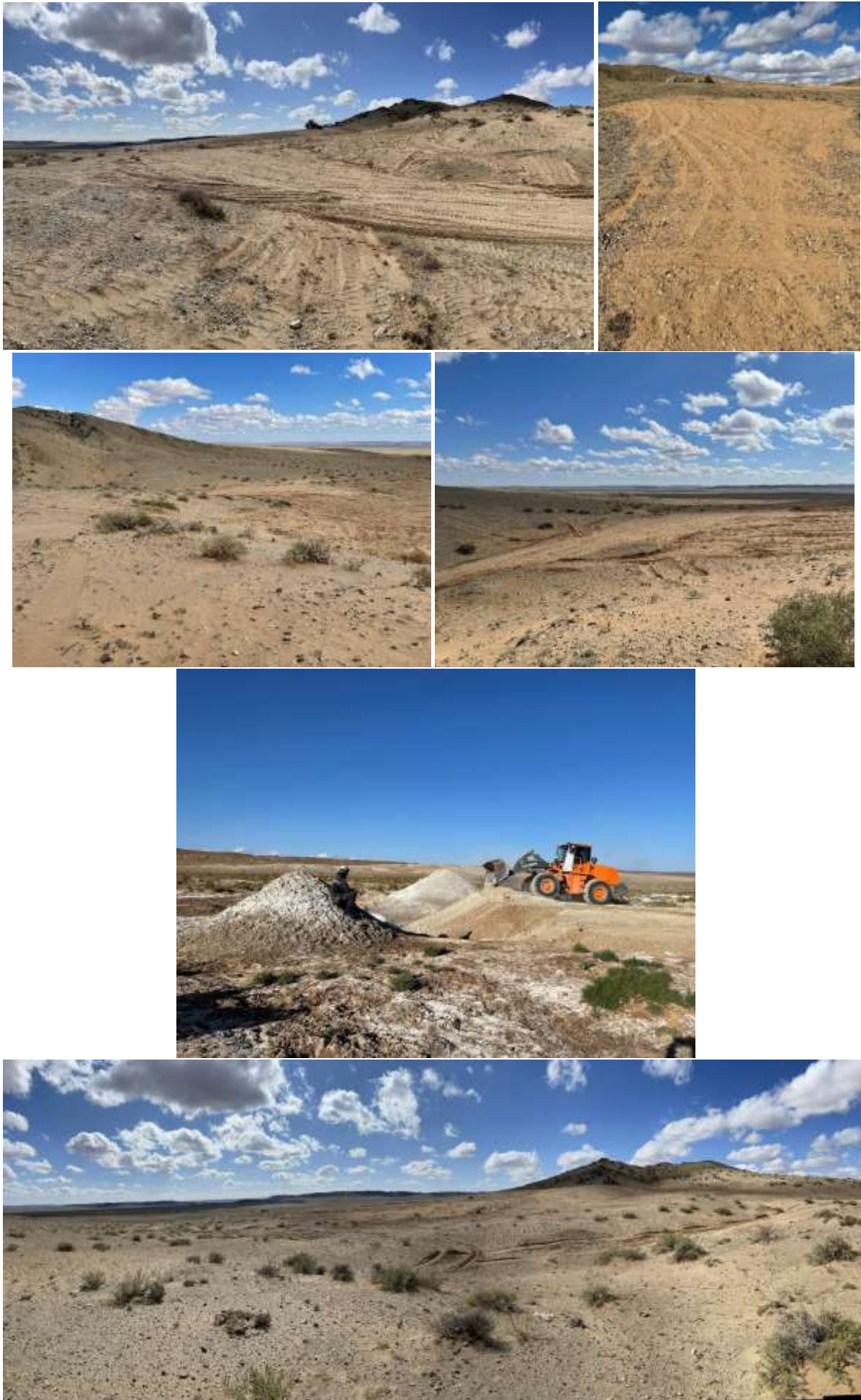
Зураг 15. Гурван ухаа шахааны амны эвдэрсэн газарт техникийн нөхөн сэргээлт хийсний дараах байдал
