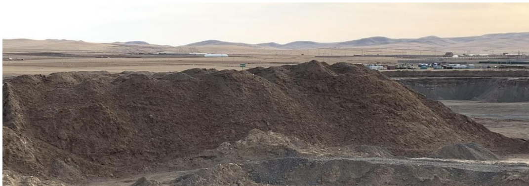
Зураг 4. Төслийн талбайд хийгдсэн шимт хөрс овоолго
