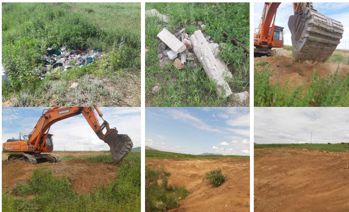
Зураг 2-11. Баян-Өлзийт сумын хуучин хогийн цэгийн 3 га талбайд техникийн нөхөн сэргээлт хийж буй байдал
