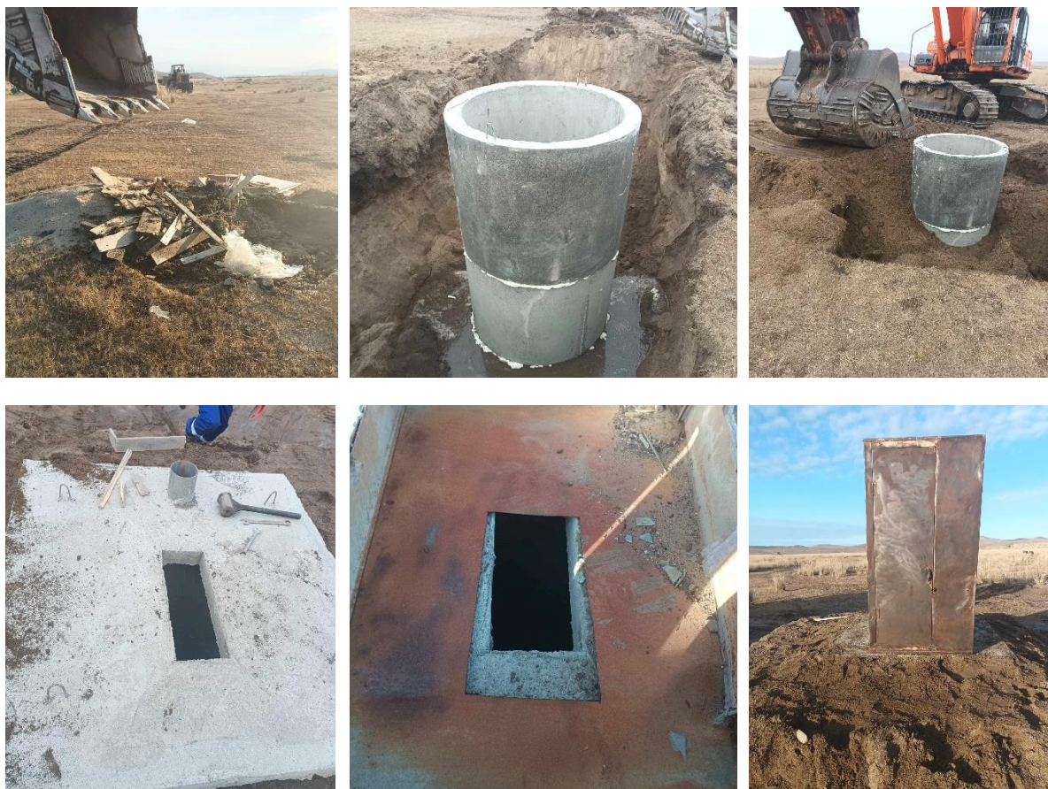
Зураг 2-7. Хуучин хэрэглэж байсан бие засах газрыг буулгаж, шинээр эко бие засах газар байгуулж буй байдал
