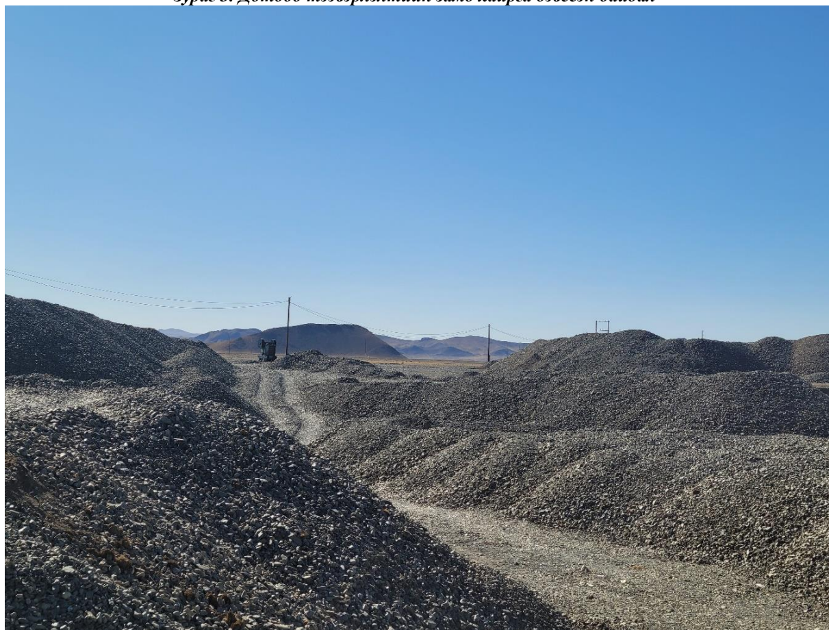
Зураг 4. Уурхайн дотоод тээврийн замыг засаж хайрга дэвссэн байдал
