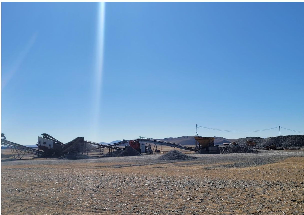
Зураг 3. Дотоод тээвэрлэлтийн замд хайрга дэвссэн байдал
