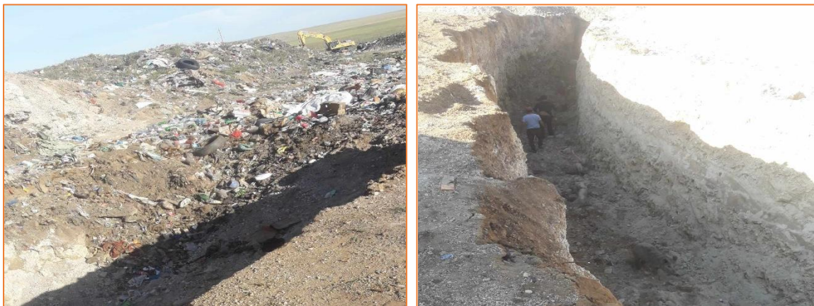
Зураг 25. Иххэт сумын төвийн хог хаягдлын төвлөрсөн цэгийн хог хаягдлыг булшлах арга хэмжээг хэрэгжүүлж буй байдал
